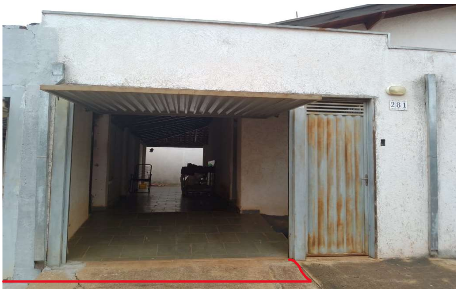
*Foto 3 – foto da garagem da casa 281, que deverá ser integrada ao imóvel de matrícula 27.044
