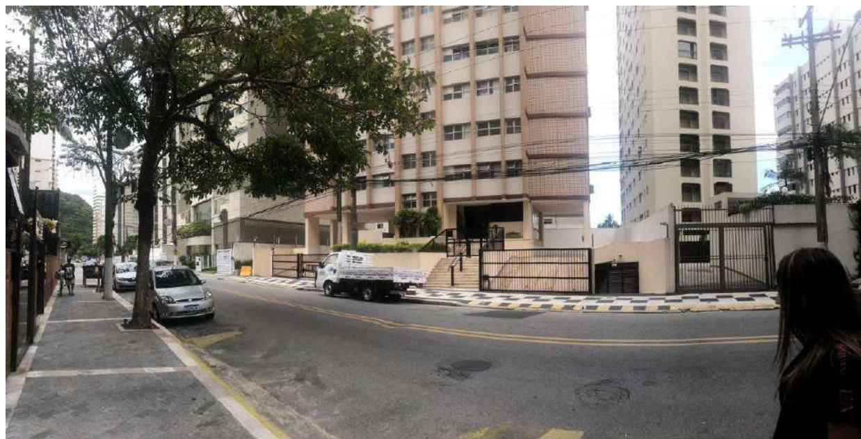
Figura 09 – Vista da frente do Edifício avaliado e trecho da Avenida General Rondon. Foto autoral.
