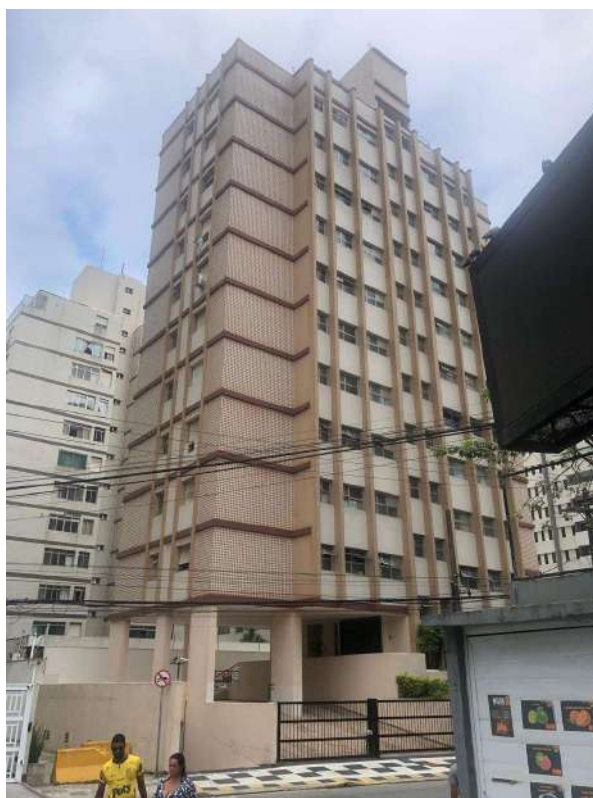
Figura 10 - Vista frontal e lateral do edifício avaliado. Foto autoral.
