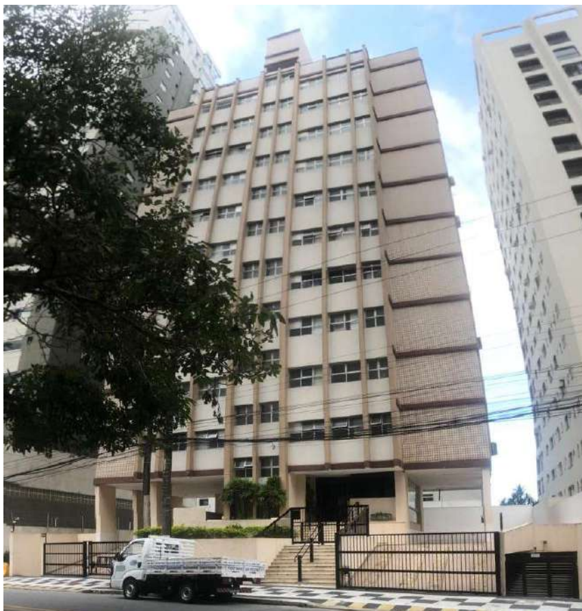
Figura 08 – Vista frente do Edifício Chander. Foto autoral.
