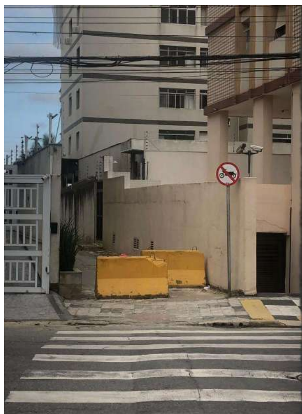
Figura 11 - Detalhe, vista do acesso para pedestres à Praia das Asturias ao lado do Edifício Chander. Foto autoral.
