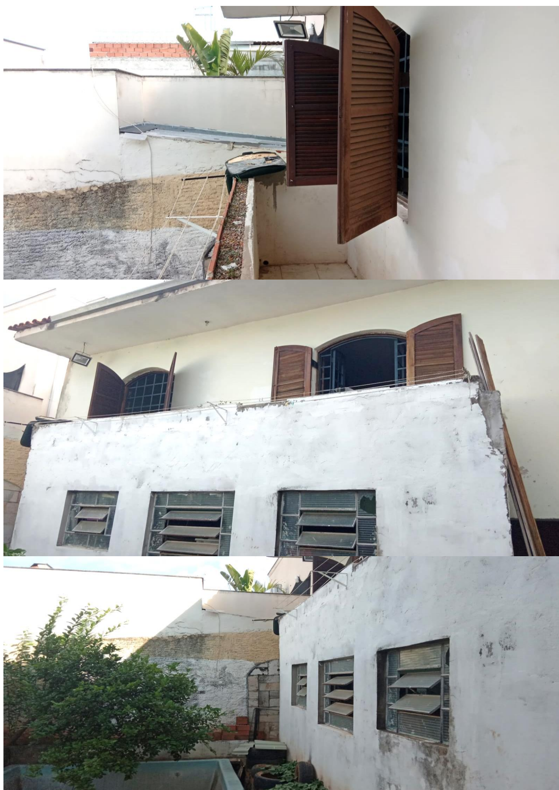
Visão dos fundos do imóvel tipo varanda
