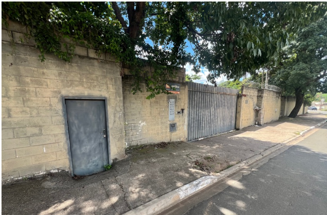
Imagem 06: Portão de entrada mais ao sul do terreno
