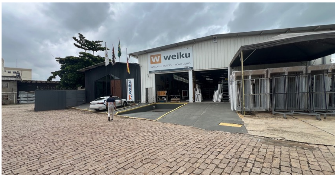
Imagem 32: Entrada principal para o galpão e showroom à esquerda, bem como muro aos fundos da empresa, já fora do imóvel em análise
