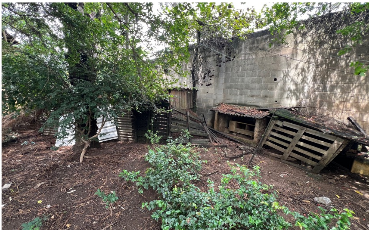
Imagem 20: Estruturas, casas e vegetação na porção mais central do imóvel
