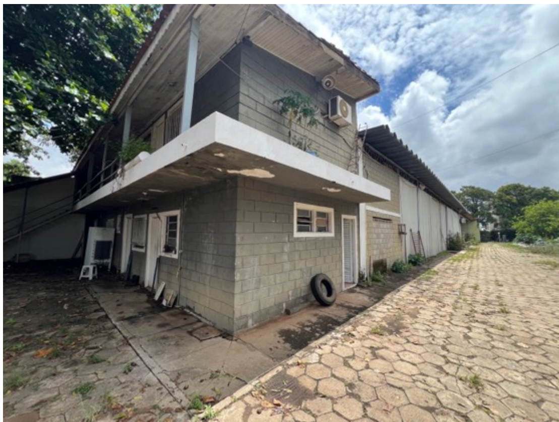
Imagem 10: Vista do portão de entrada para o galpão
