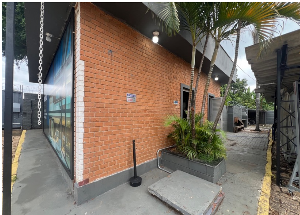
Imagem 30: Portaria da empresa Weiko, sendo que parte dessa edificação se encontra dentro da delimitação do imóvel
