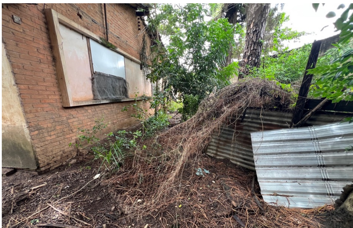
Imagem 21: Estruturas, casas e vegetação na porção mais central do imóvel
