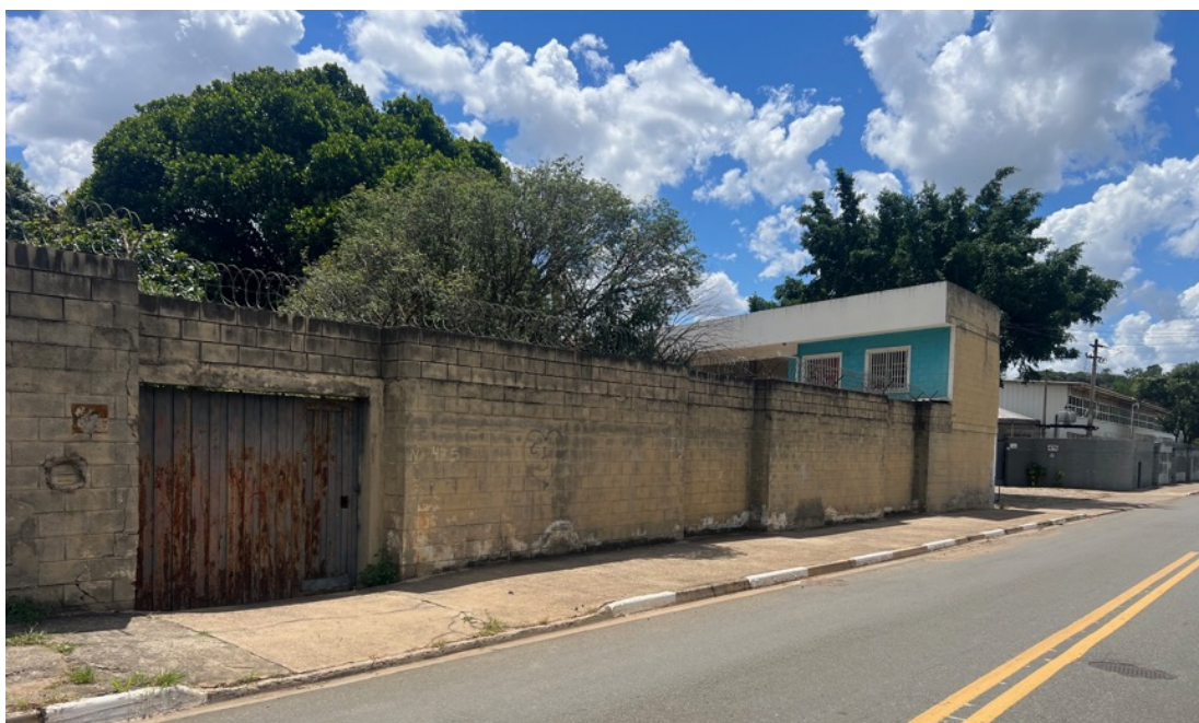
Imagem 07: Portão de entrada mais ao centro do terreno
