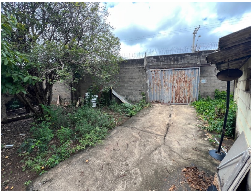
Imagem 27: Vista de dentro do portão de acesso mais ao centro da fechada
