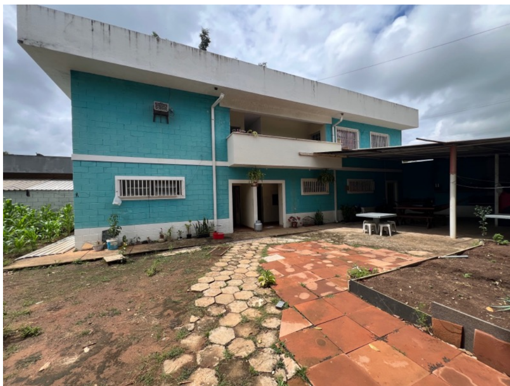
Imagem 27: Casa na próxima à porção central do terreno, porém fora da delimitação do imóvel
