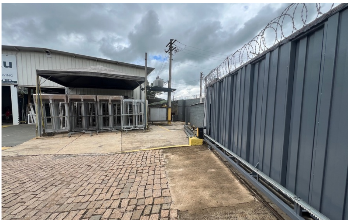
Imagem 31: Portão de acesso para a empresa Weiko e porção do galpão que se encontra dentro da delimitação do terreno
