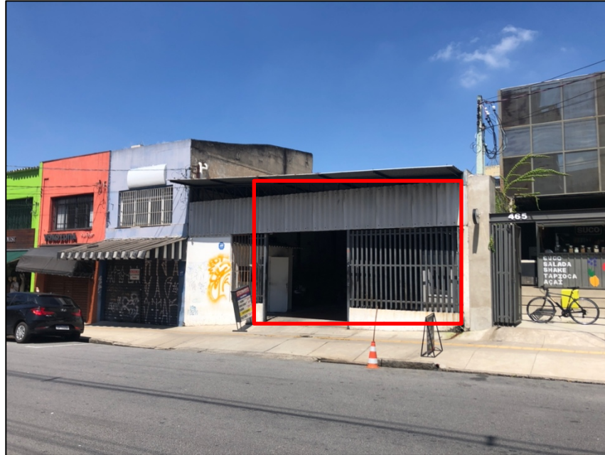
Foto 01 – Frente do imóvel
