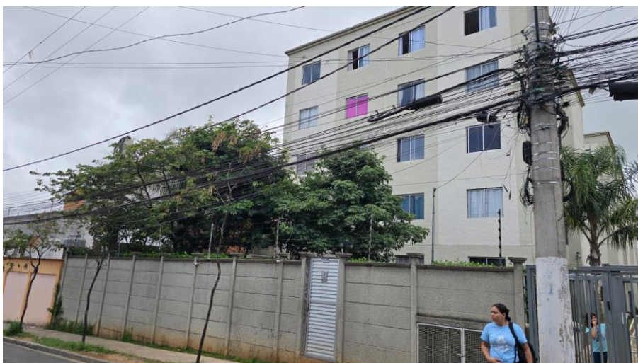
Outra vista interna do empreendimento onde se localiza o imóvel
