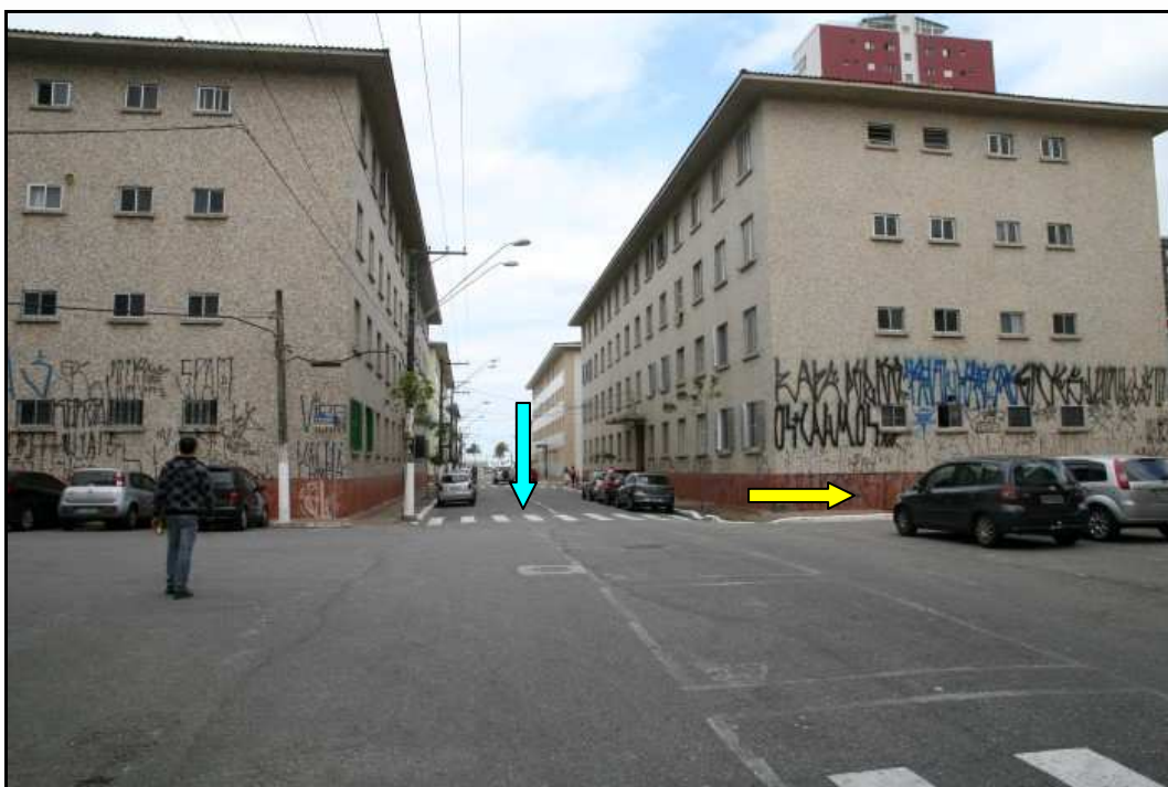
FOTOS 53/54 - Vista do Condomínio Garagem Ocian (acesso pela Avenida Dom Pedro II). A seta azul indica a Avenida Dom Pedro II.
