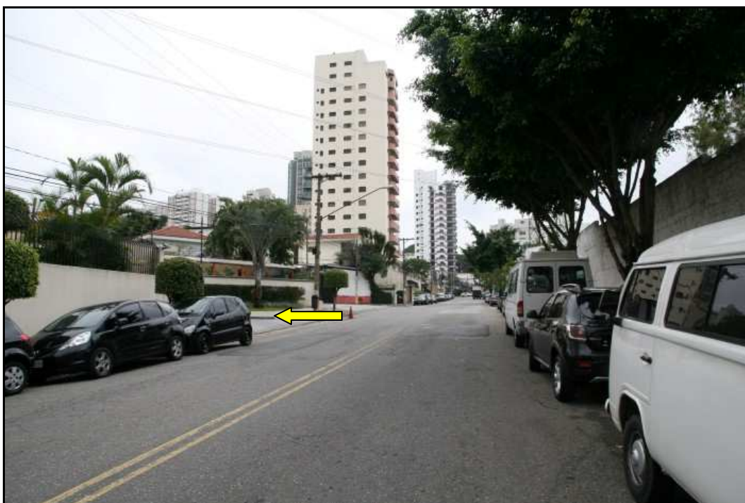
FOTOS 3/4 - Vista da Rua Vitoantonio del Vecchio. A seta amarela indica o Edifício Castellamare di Stabia.
