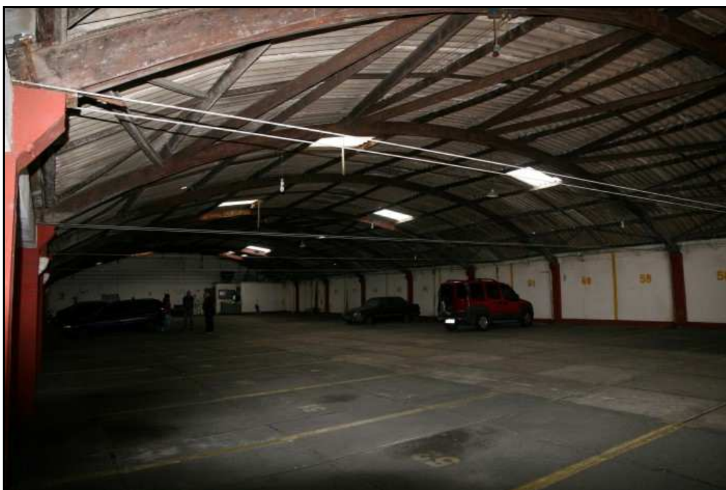
FOTOS 60/61 - Vista do Condomínio Garagem Ocian.
