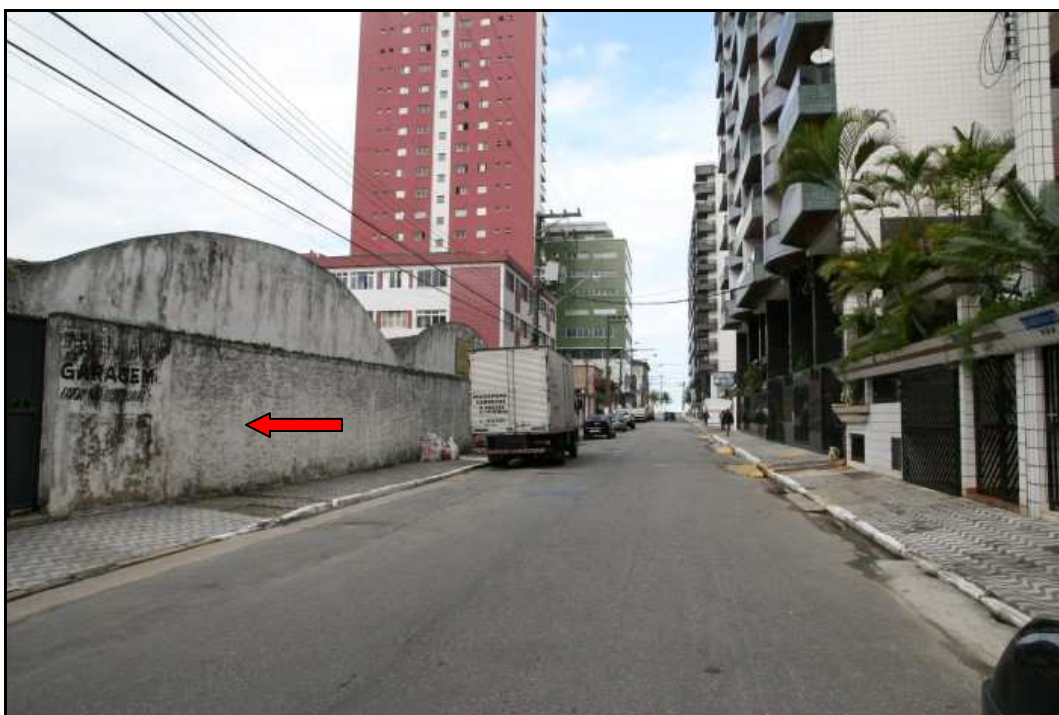
FOTOS 58/59 - Vista da Rua Oceânica Amábil. A seta vermelha indica o Condomínio Garagem Ocian.
