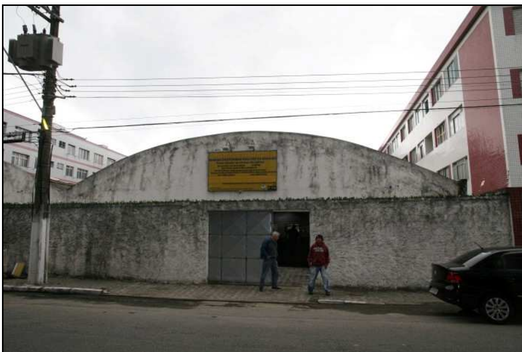
FOTOS 56/57 - Vista do Condomínio Garagem Ocian (acesso pela Rua Oceânica Amábile).
