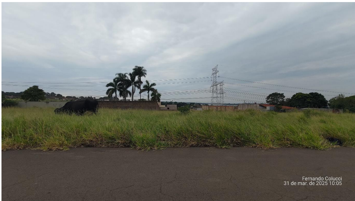
Figura 7 - Vista frontal do imóvel
