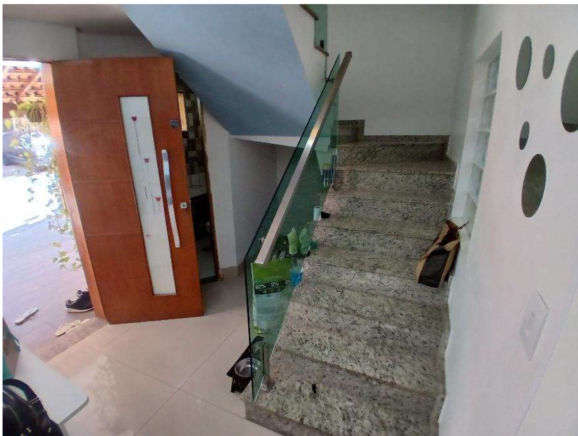
Objeto Pericial – Acesso ao 2º pavimento
