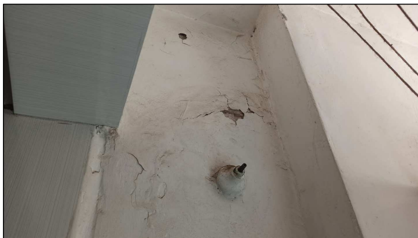
Foto 13. Área de Serviço
