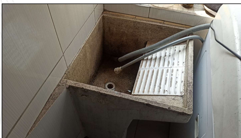
Foto 15. Área de Serviço
