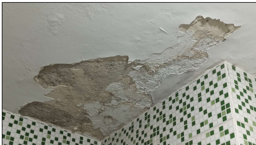
Foto 20. Detalhe do Banheiro
