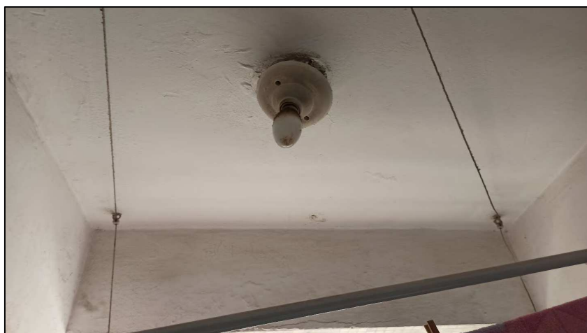
Foto 14. Área de Serviço
