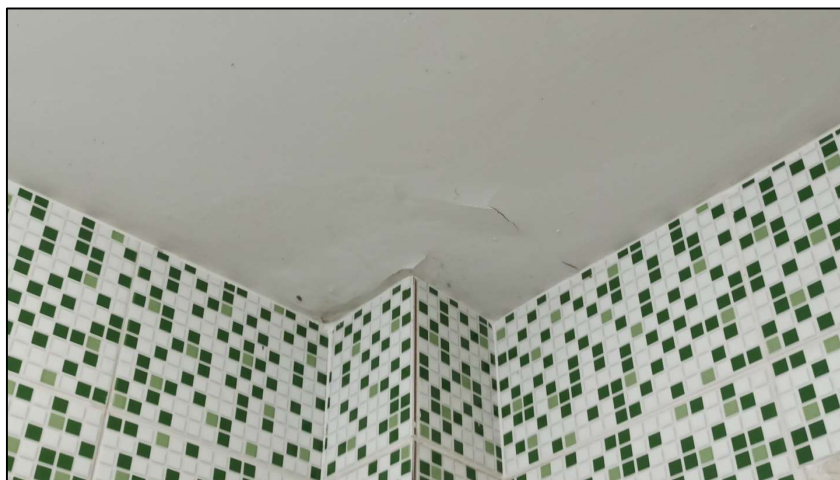
Foto 19. Detalhe do Banheiro
