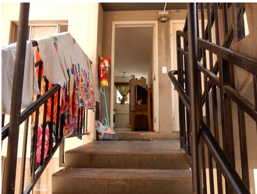
Acesso ao apartamento nº 203
