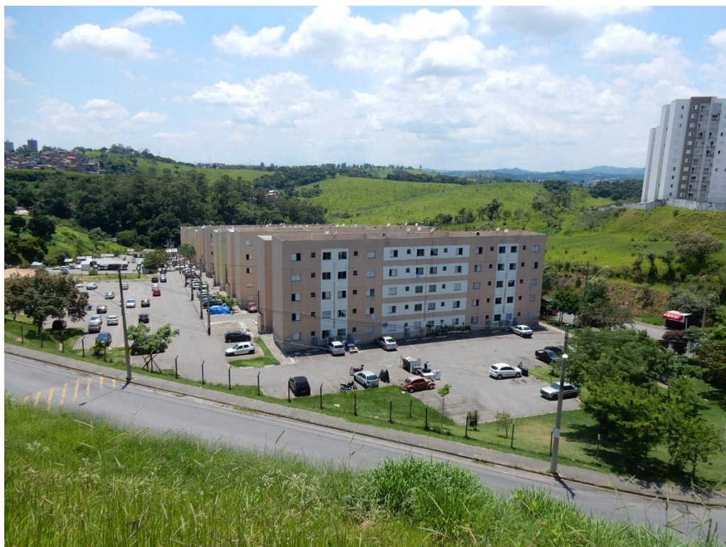
Condomínio Tupi I e II
