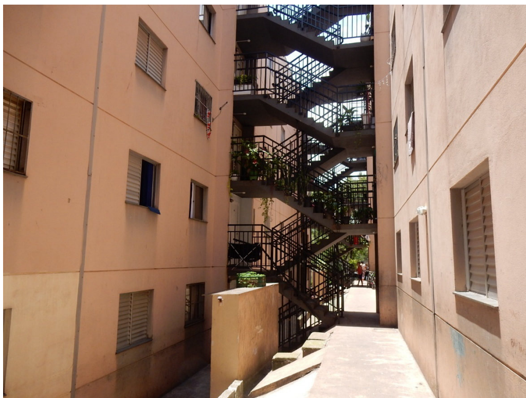
Acesso aos apartamentos do Bloco 3
