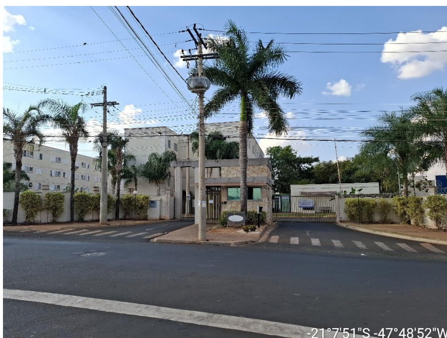
Foto 2 - Vista da fachada do condomínio Remanso do Bosque
