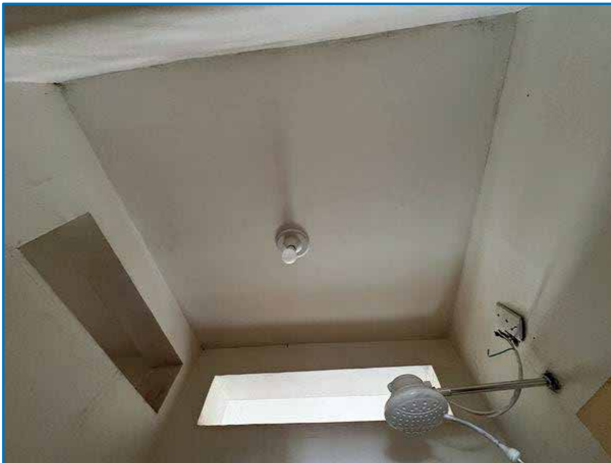
Foto 27 - Detalhe do acabamento do revestimento de teto do banheiro inferior 02 da Edificação Principal.
