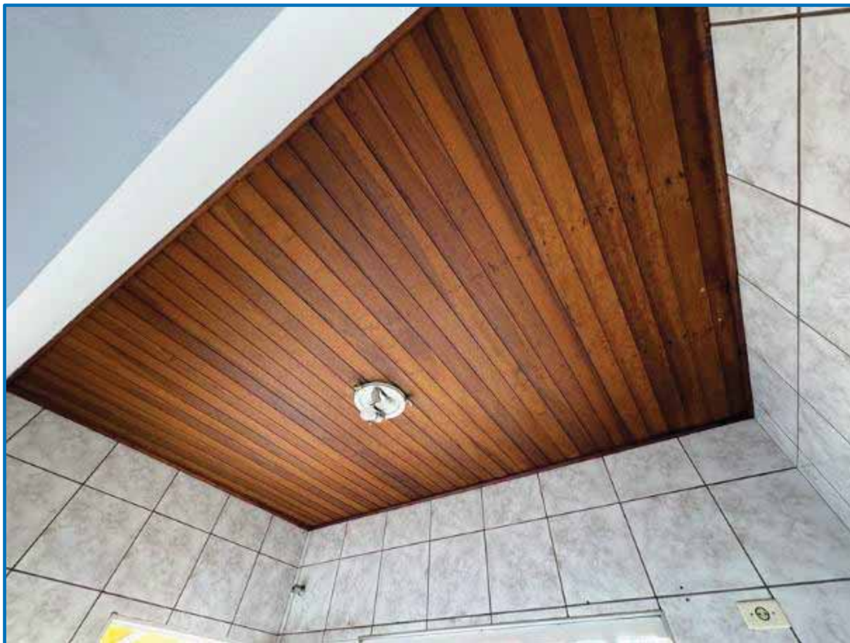
Foto 150 - Detalhe do acabamento do revestimento de teto da cozinha da Edícula .
