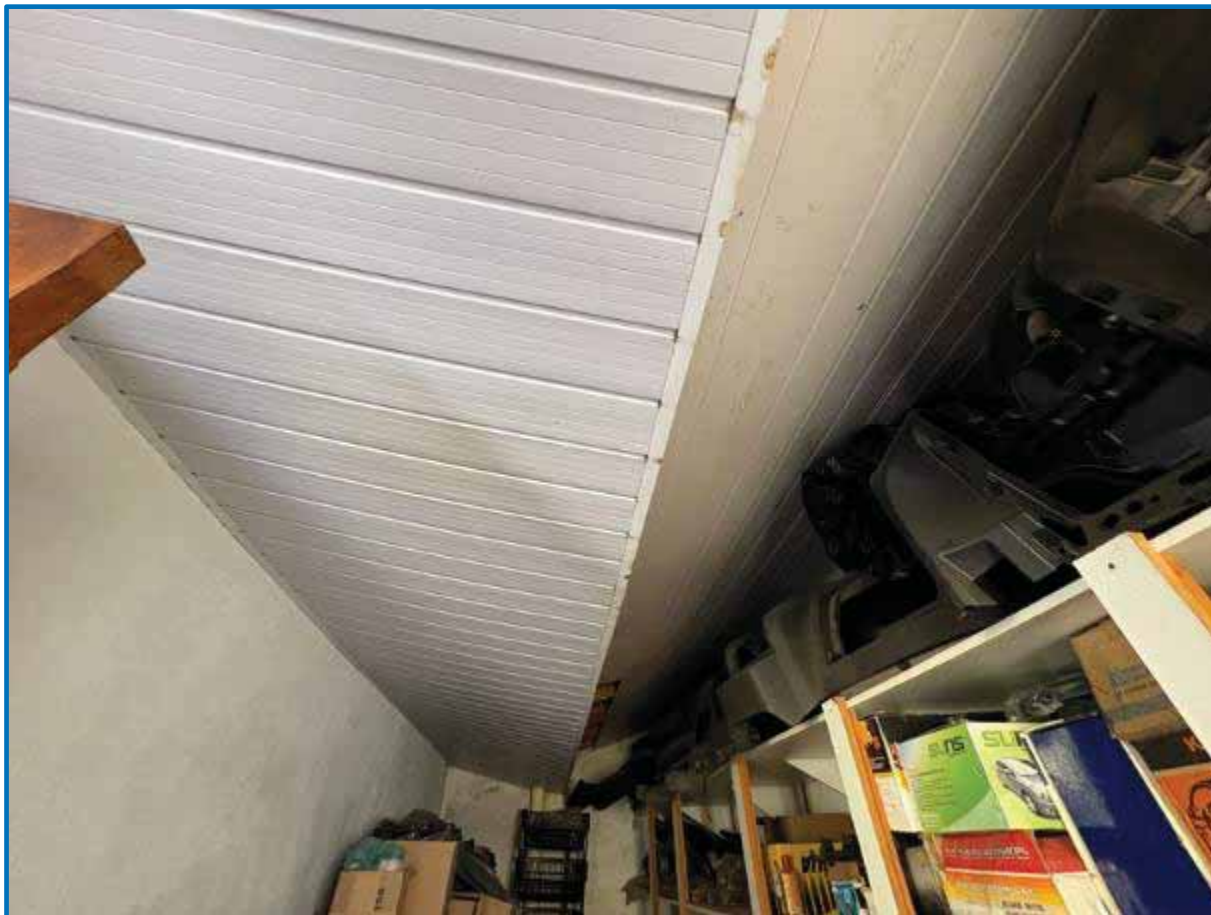
Foto 130 - Detalhe do acabamento do revestimento de teto do depósito da Área da Churrasqueira .
