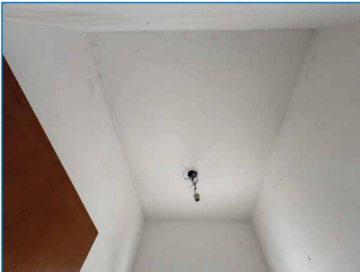
Foto 59 - Detalhe do acabamento do revestimento de teto do banheiro superior 02 da Edificação Principal .
