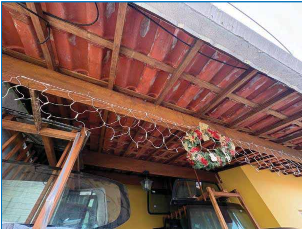
Foto 145 - Detalhe do acabamento do revestimento de teto da garagem da Edícula .
