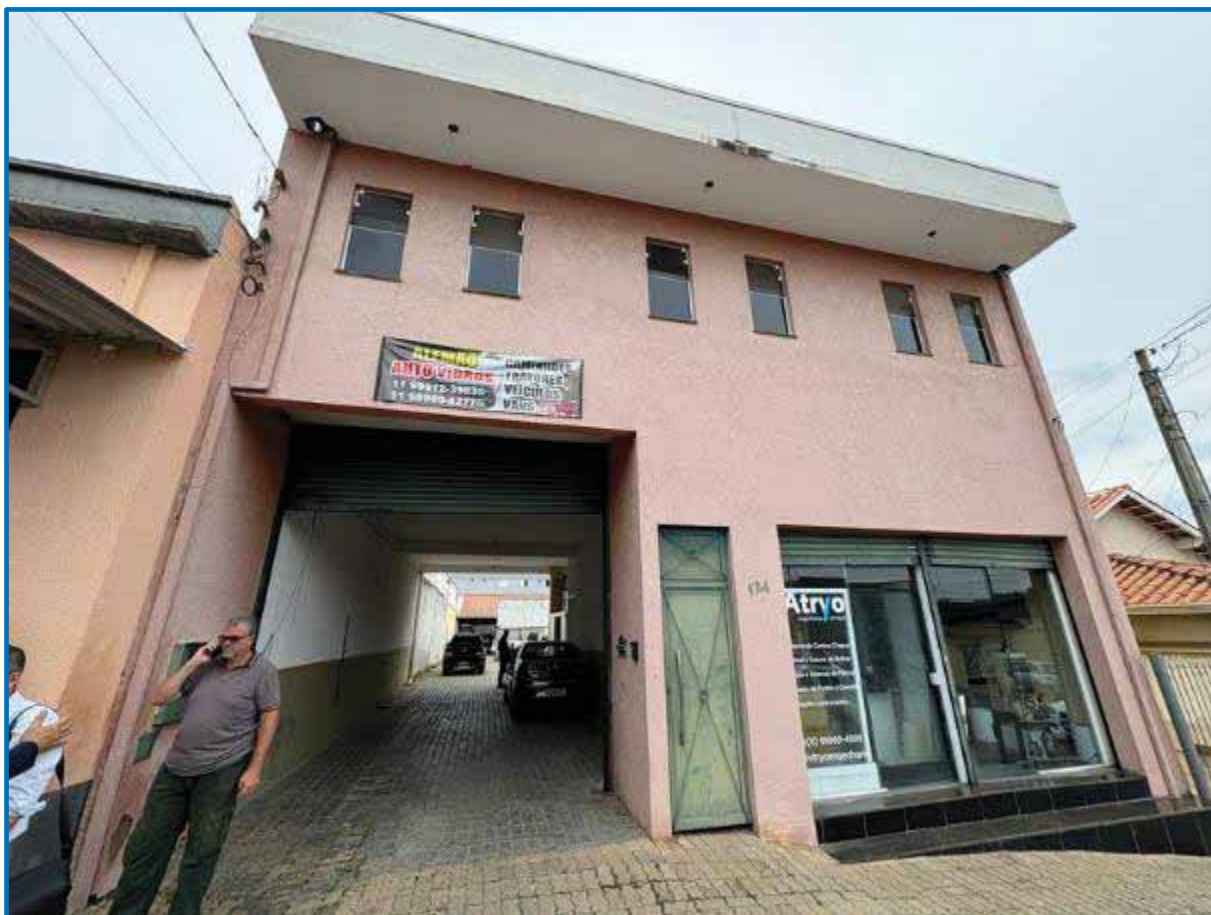
Foto 04 – Vista geral da fechada frontal da Edificação Principal erigida sobre o terreno.
