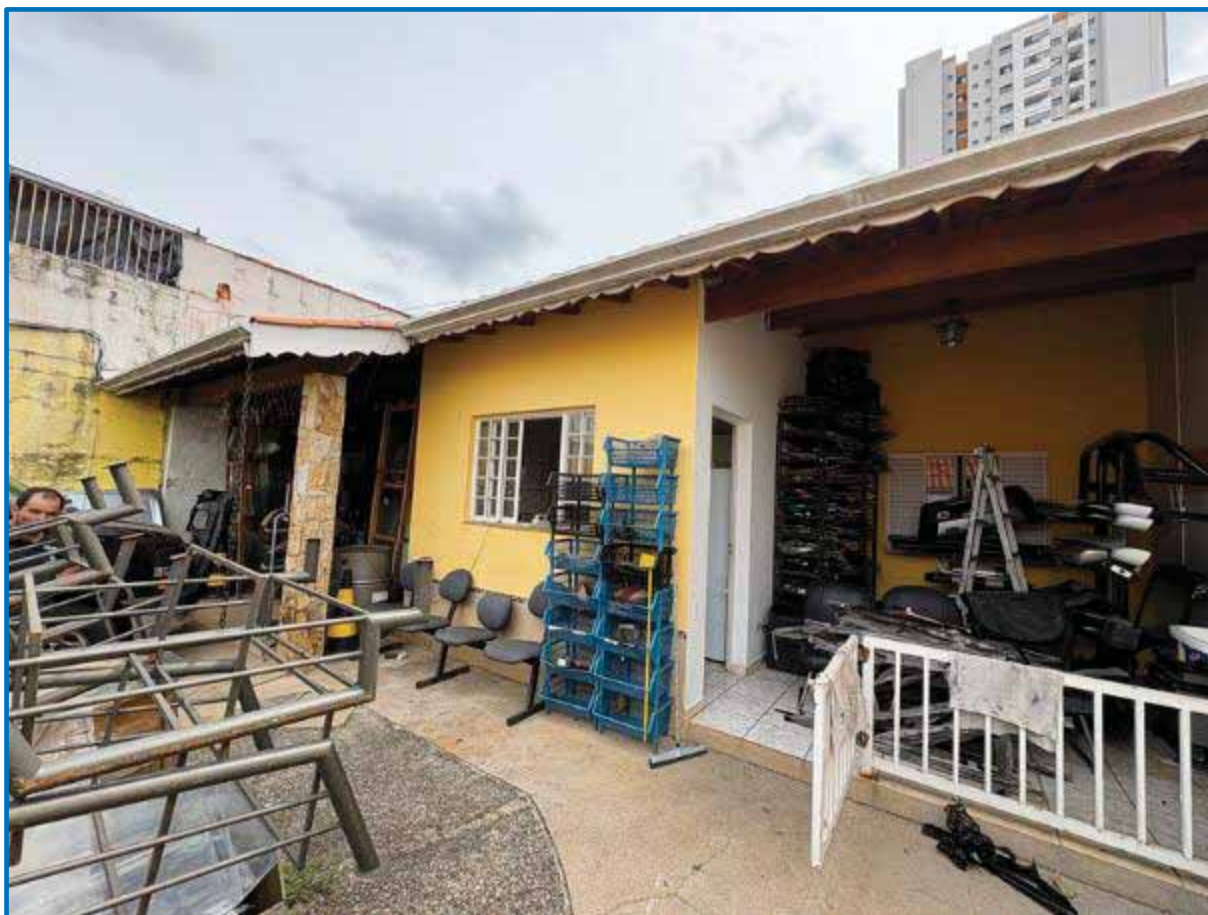
Foto 141 - Vista da Edícula , situada no trecho posterior do imóvel avaliando.
