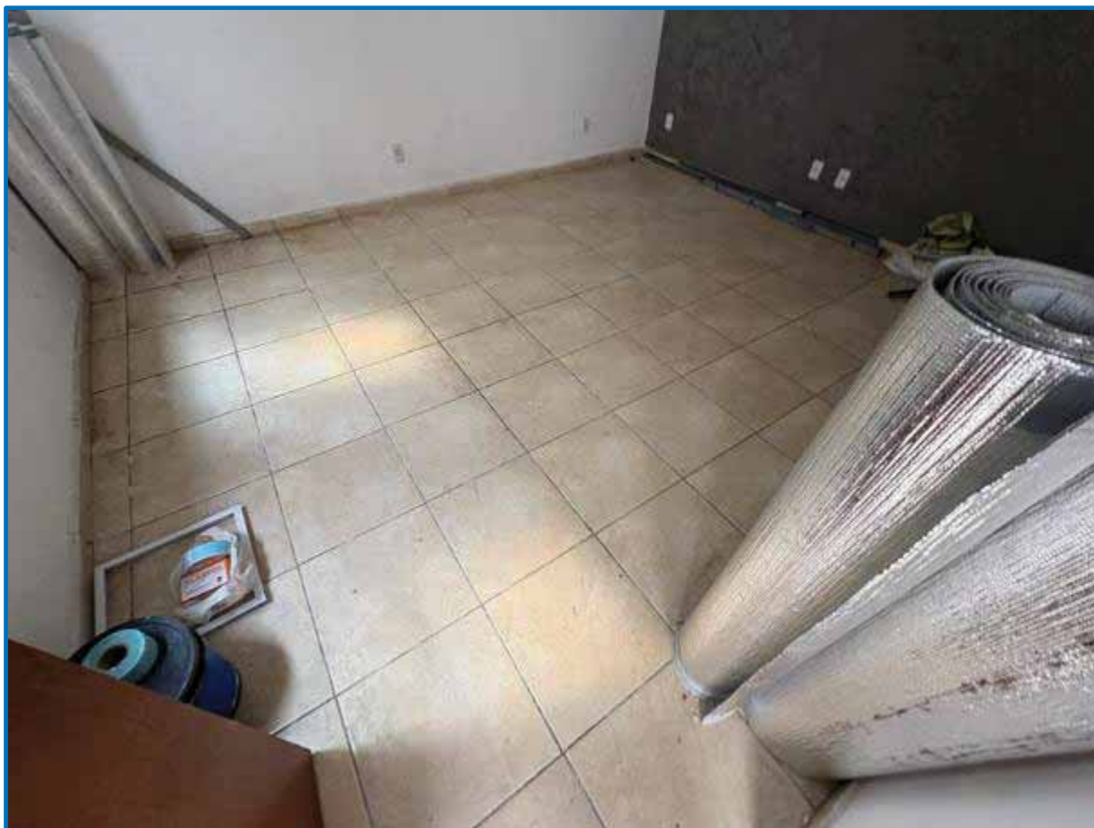
Foto 97 - Detalhe do acabamento do revestimento de piso da sala superior 03 da Edificação Principal.
