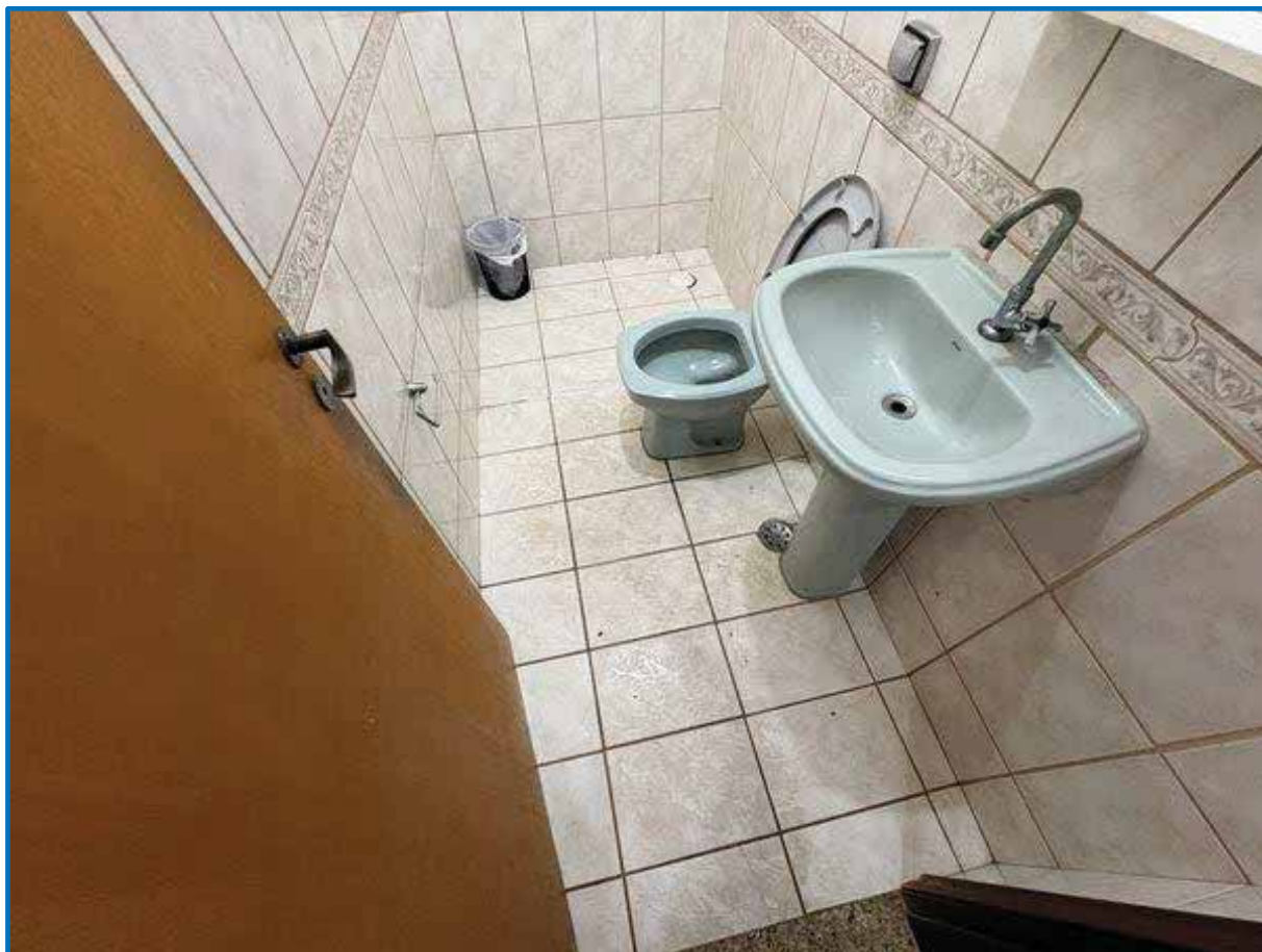
Foto 162 - Detalhe do acabamento do revestimento de piso do banheiro da Edícula .
