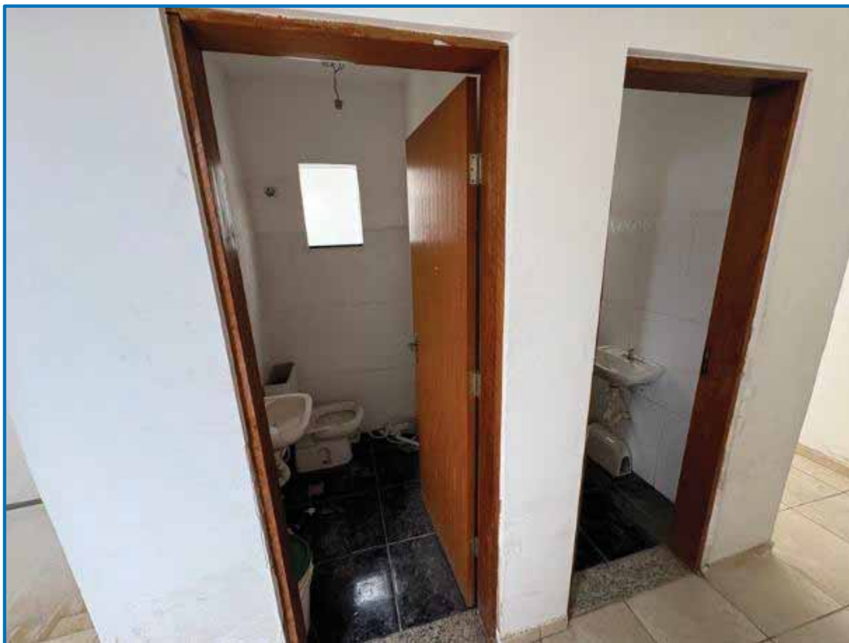
Foto 51 - Vista da porta de acesso aos banheiros do pavimento superior da Edificação Principal .
