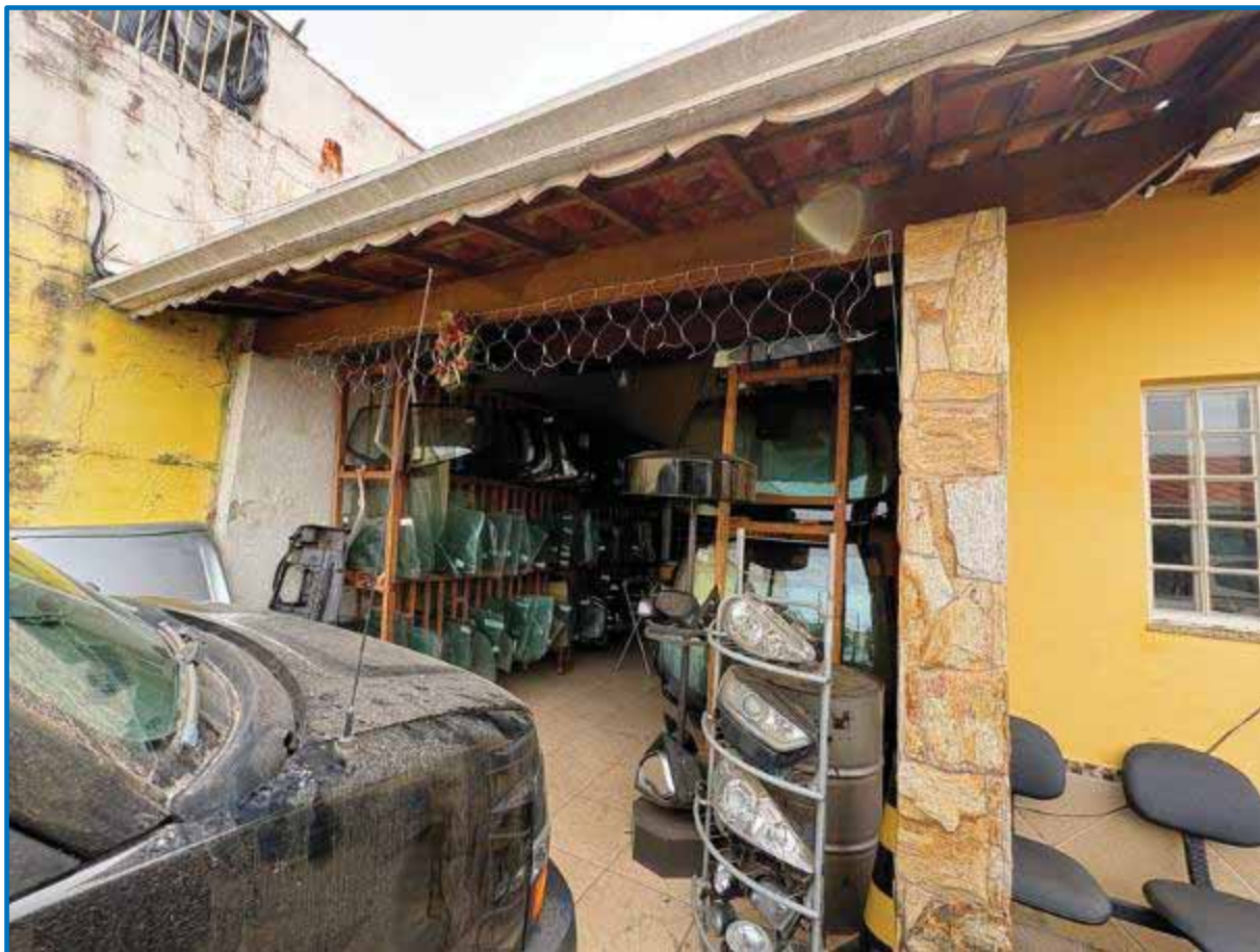
Foto 142 - Vista da cobertura da garagem da Edícula .
