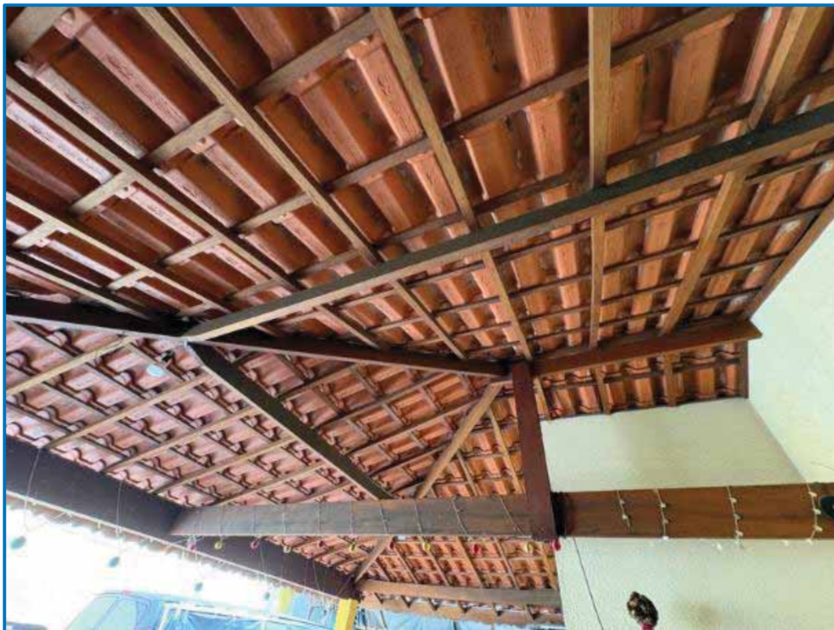
Foto 134 - Detalhe do acabamento do revestimento de teto da Área da Churrasqueira .
