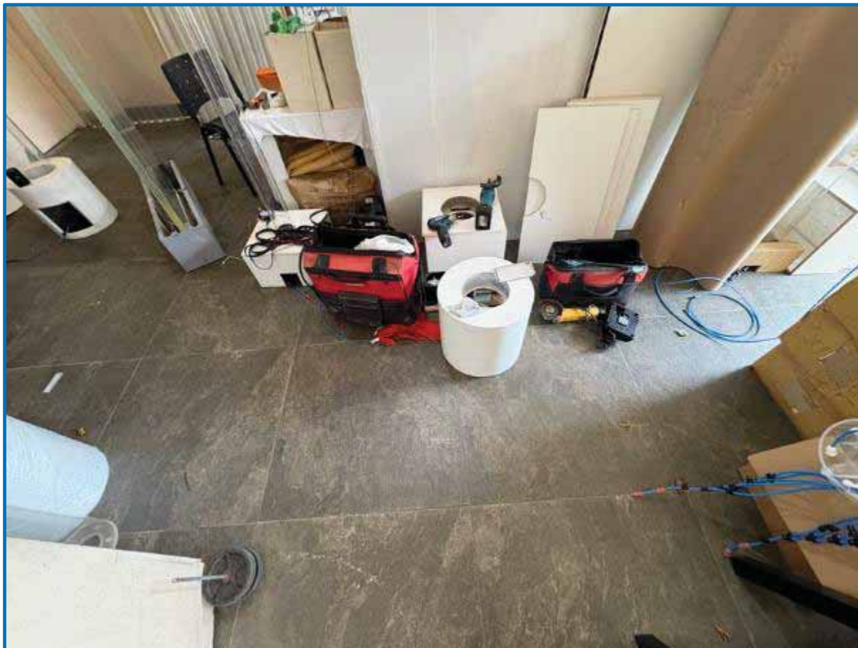
Foto 11 - Detalhe do acabamento do revestimento de piso do salão inferior da Edificação Principal .
