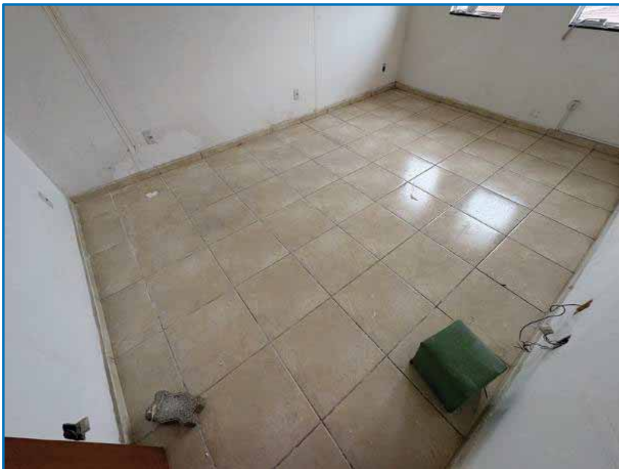
Foto 105 - Detalhe do acabamento do revestimento de piso da sala superior 04 da Edificação Principal.
