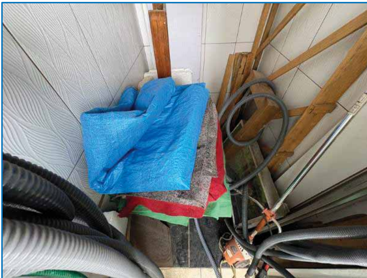
Foto 35 - Detalhe do acabamento do revestimento de piso do banheiro inferior 03 da Edificação Principal.
