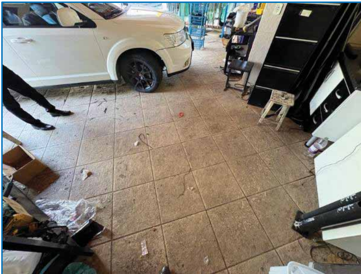
Foto 133 - Detalhe do acabamento do revestimento de piso da Área da Churrasqueira.
