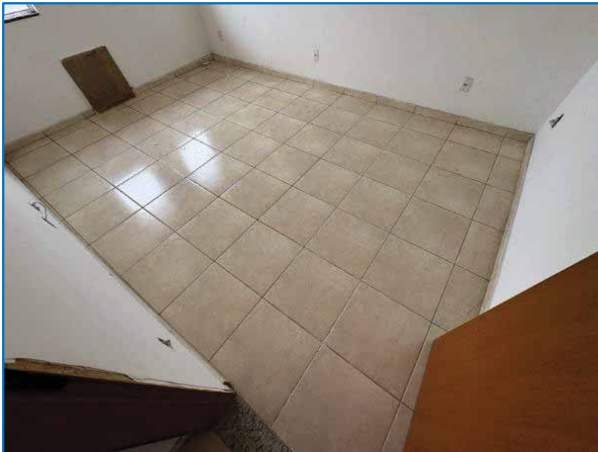
Foto 117 - Detalhe do acabamento do revestimento de piso da sala superior 06 da Edificação Principal .
