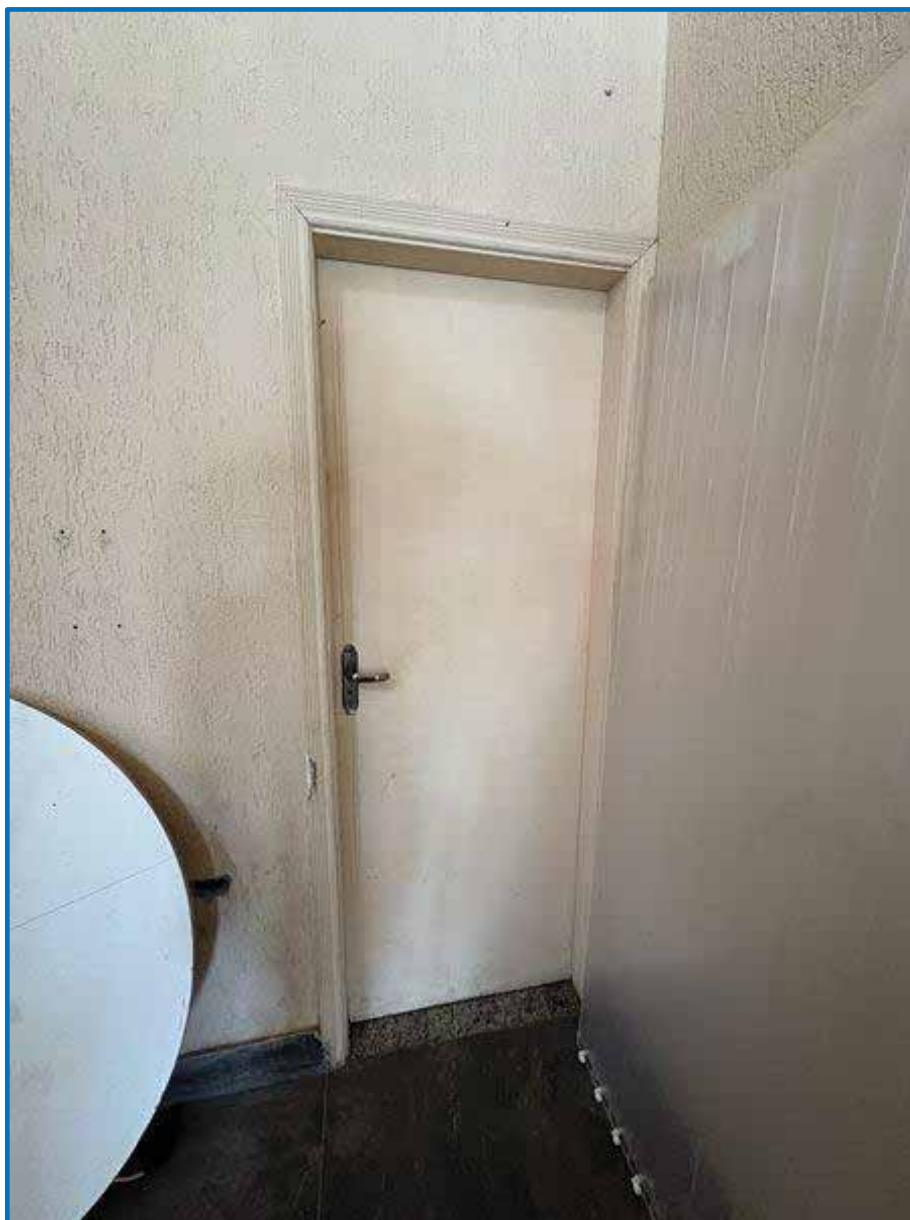
Foto 23 - Vista da porta de acesso ao banheiro inferior 02 (lado direito).
