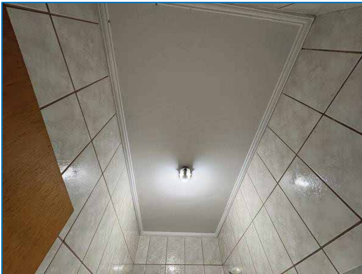
Foto 163 - Detalhe do acabamento do revestimento de teto do banheiro da Edícula .
