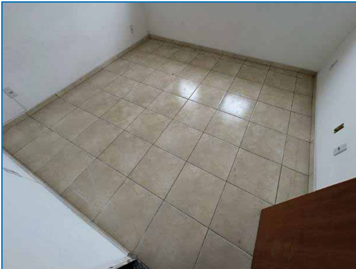
Foto 111 - Detalhe do acabamento do revestimento de piso da sala superior 05 da Edificação Principal .
