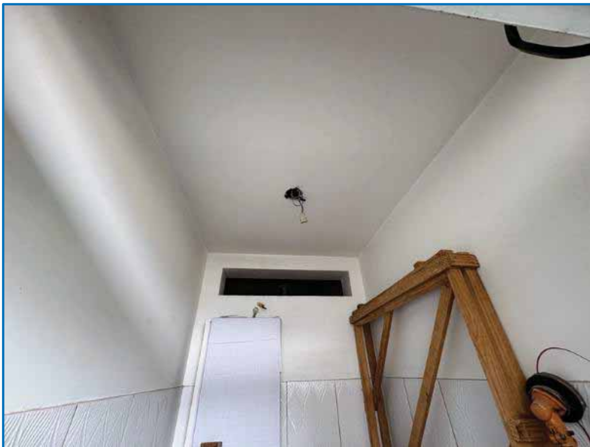
Foto 36 - Detalhe do acabamento do revestimento de teto do banheiro inferior 03 da Edificação Principal.
