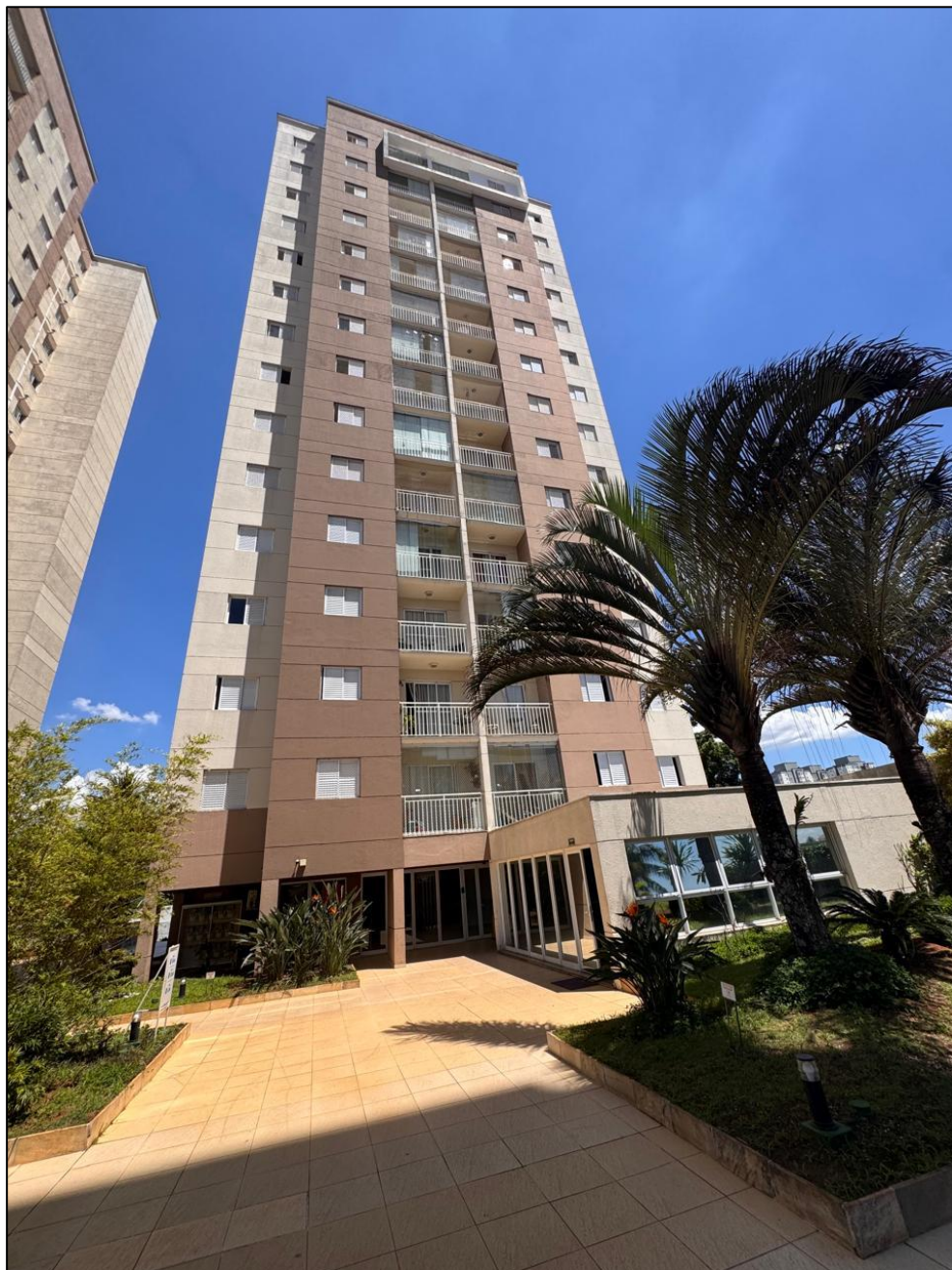
Fachada da Torre 2 – Edifício Lake .
