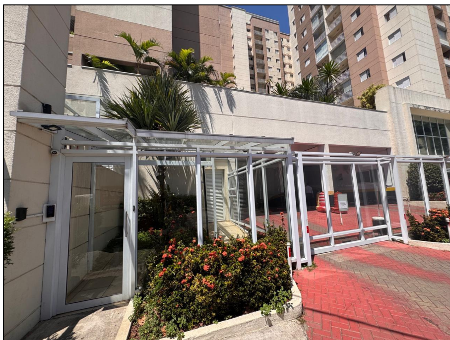
Entrada/saída de veículos – acesso a garagem nos subsolos.
