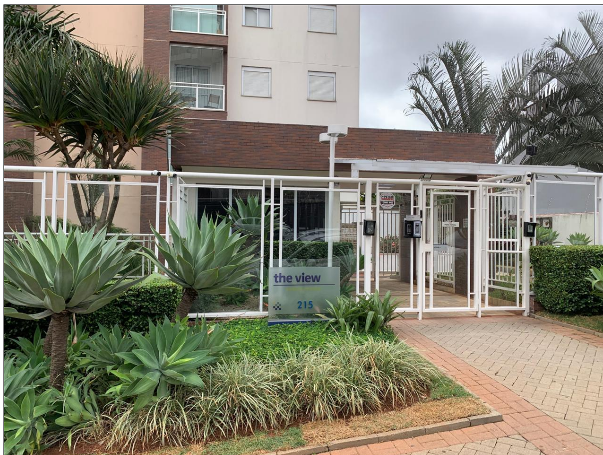
A guarita do imóvel vista da rua Cabo Basílio Zequim Júnior.
