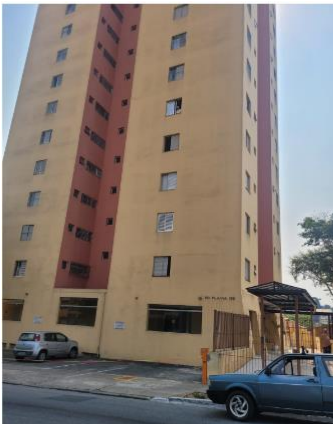
Vista do Imóvel Avaliando
