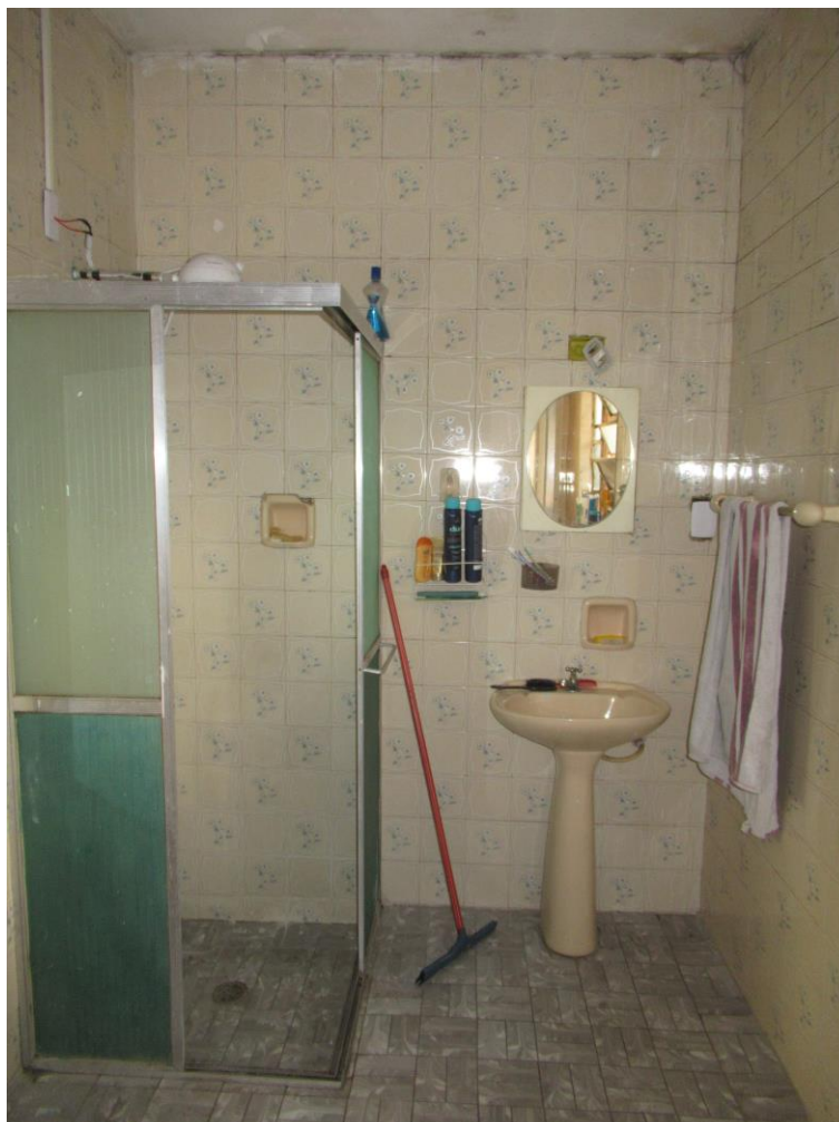
Foto nº. 13 – Outra vista do banheiro social 1.
