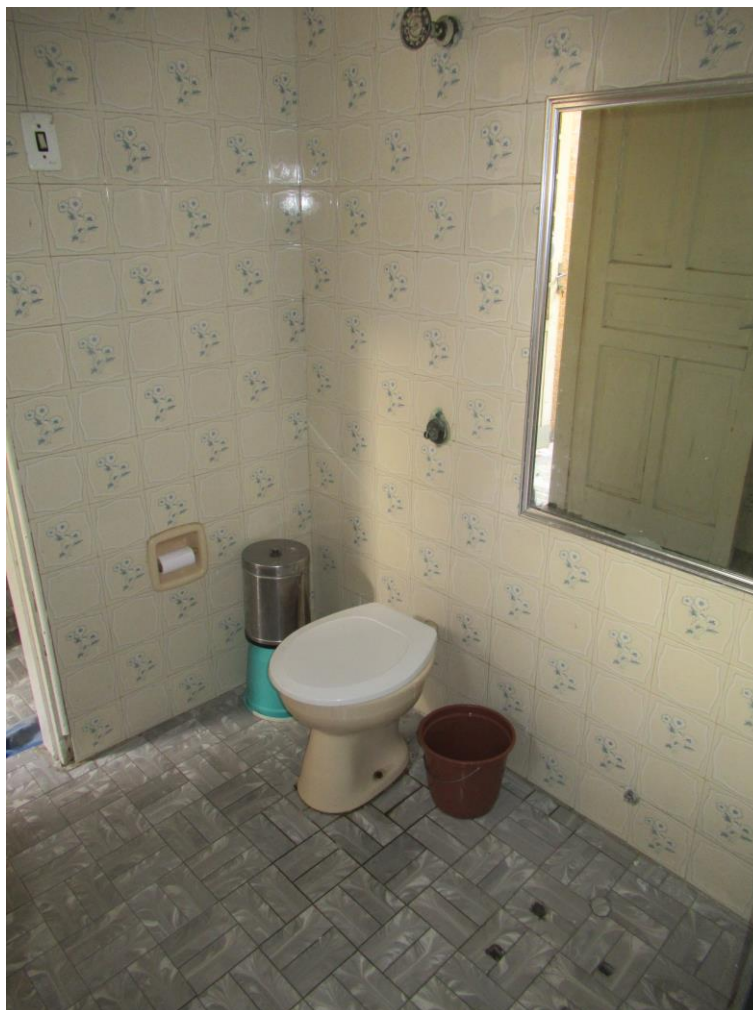
Foto nº. 12 – Vista do banheiro social 1.
