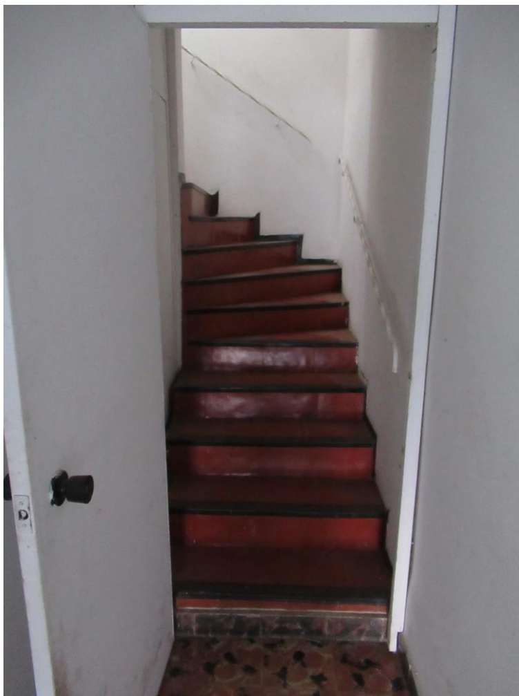
Foto nº. 17 – Vista da escada de acesso ao pavimento superior.
