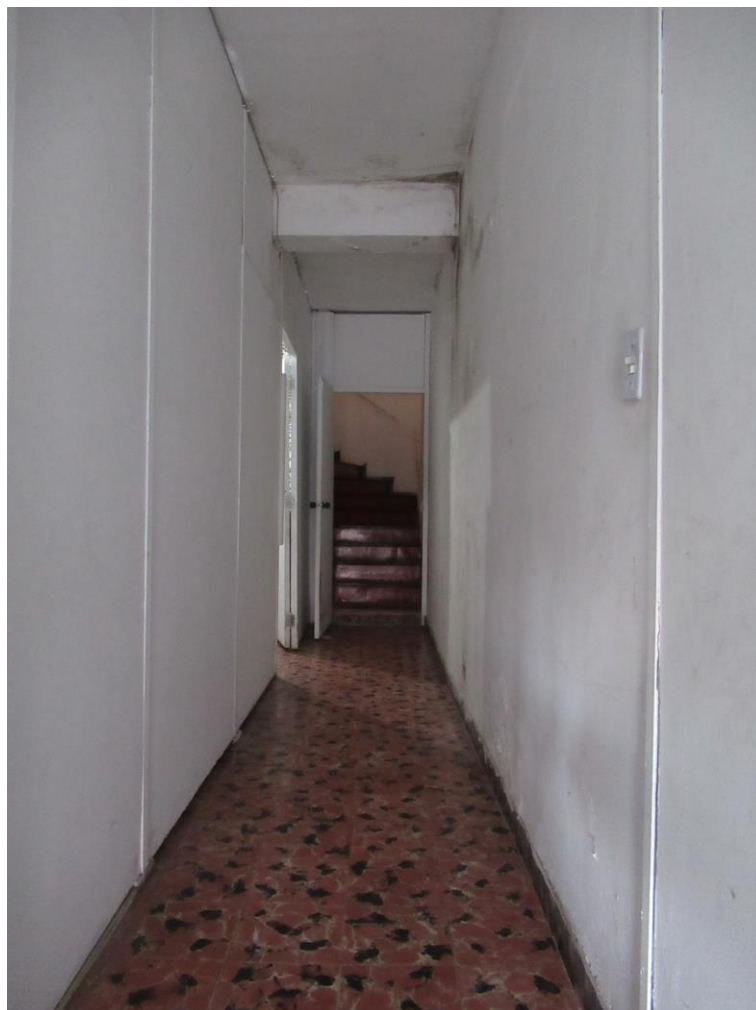
Foto nº. 5 – Vista do corredor lateral.
