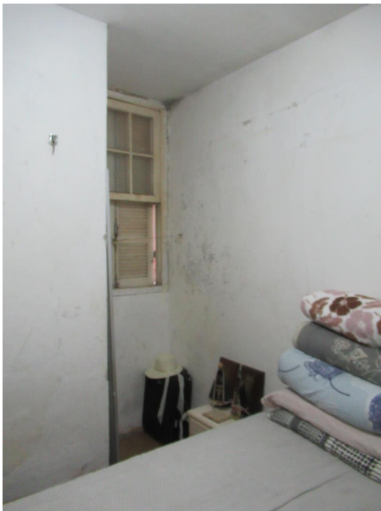
Foto nº. 11 – Outra vista do dormitório 2.
