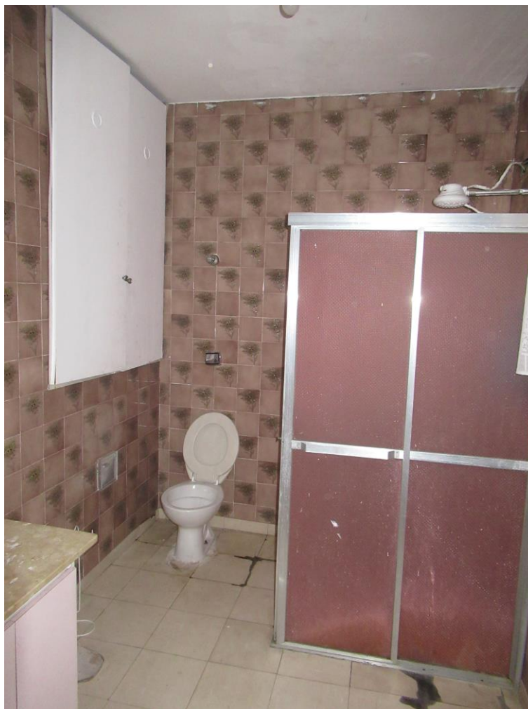
Foto nº. 19 – Vista do banheiro social 2.
