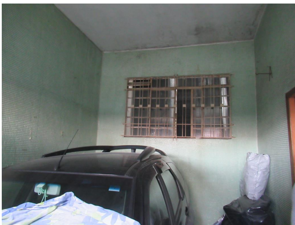
Foto nº. 4 – Vista da garagem.
