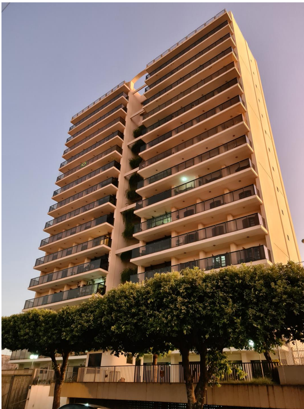
Fachada do edifício, vista em perspectiva.
