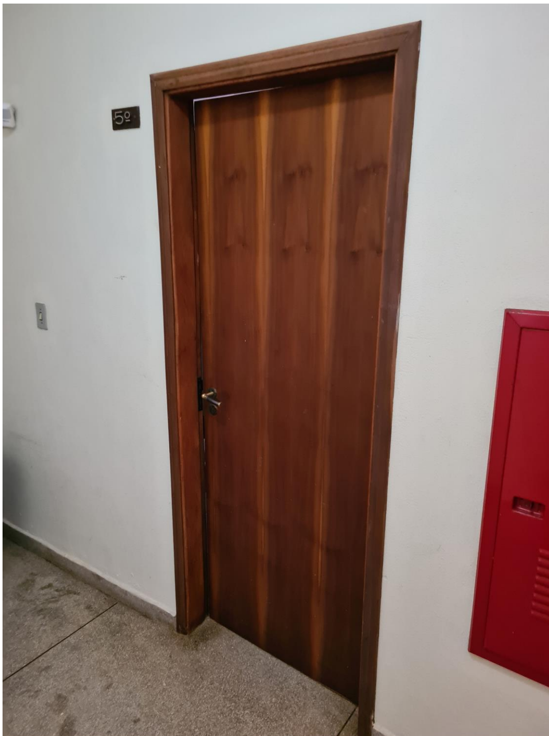
Vista da porta de entrada do depósito externo, à partir do hall de entrada de serviço.
