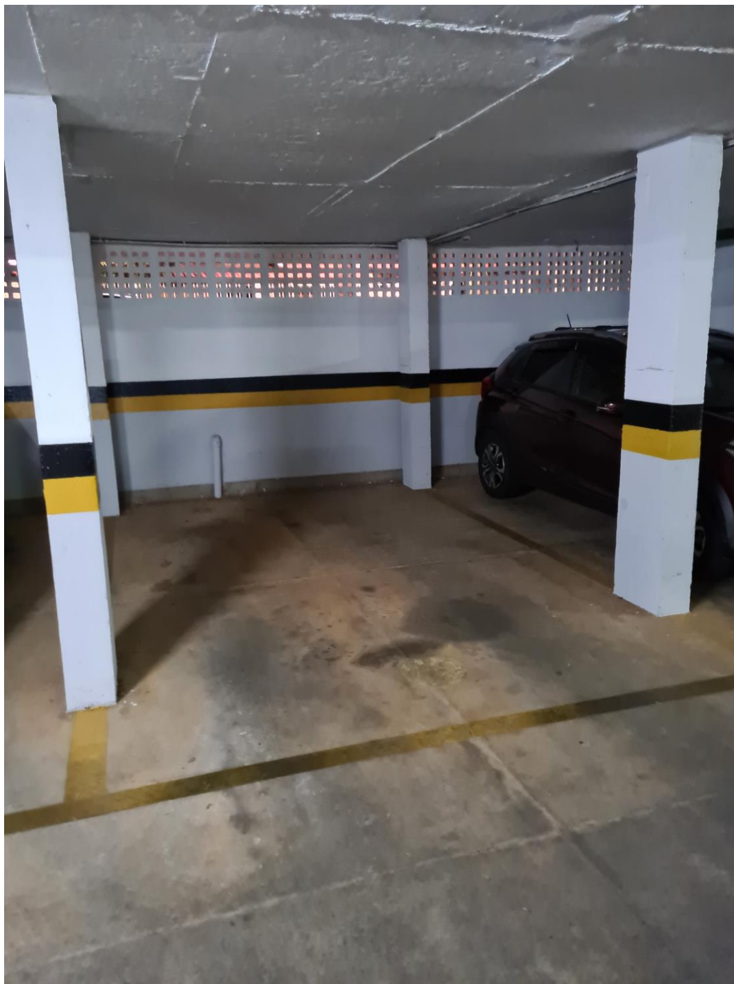
Vista da vaga de estacionamento 1, em perspectiva, na garagem subterrânea.
