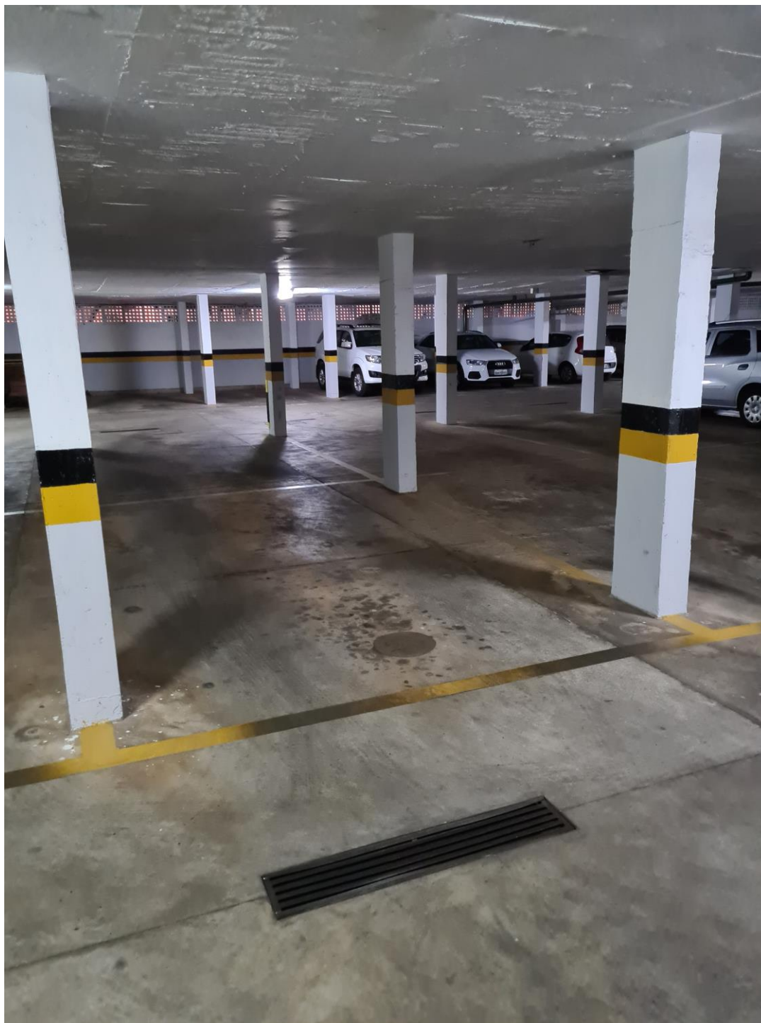
Vista da vaga de estacionamento 2, em perspectiva, na garagem subterrânea.
