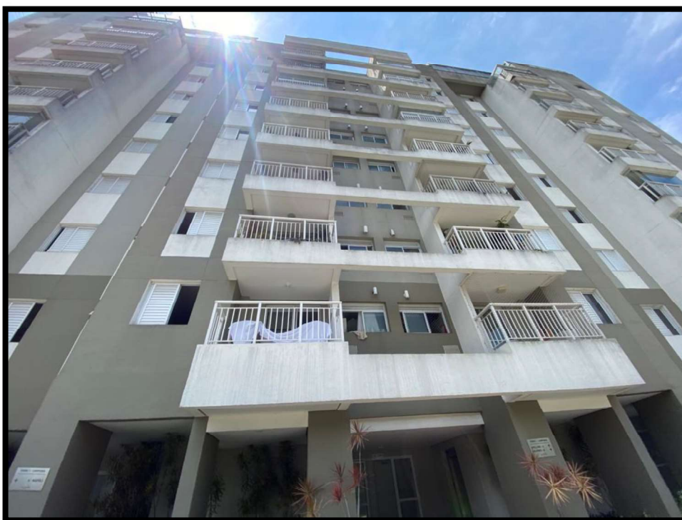
Imagem 7 – Fachada do Edifício
