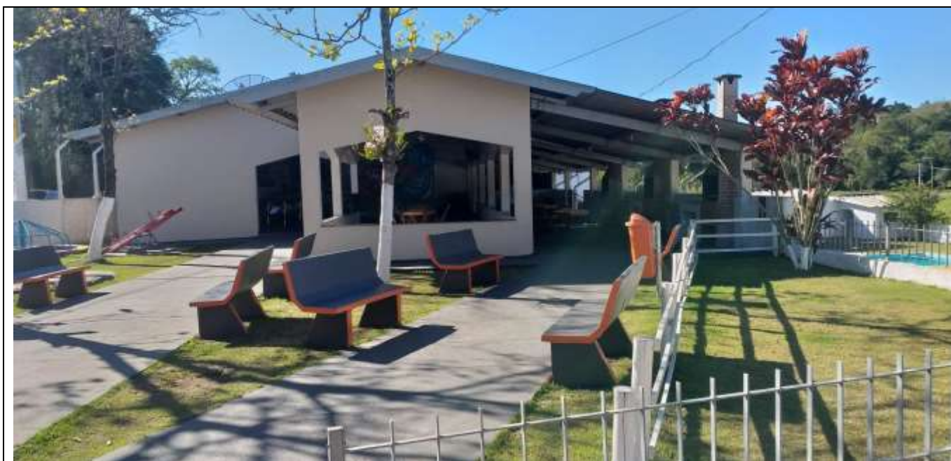
Figura 4- Vista da edificação principal
