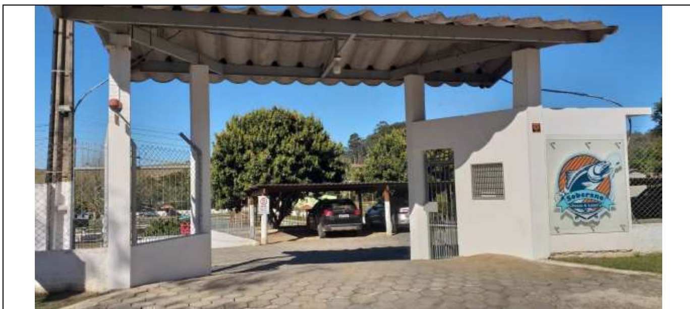
Figura 1 – Vista frontal do imóvel
