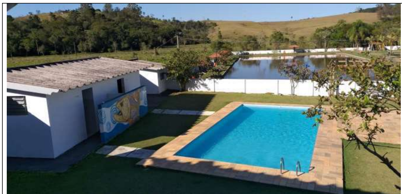
Figura 14- Sanitários/piscina/casa de máquinas
