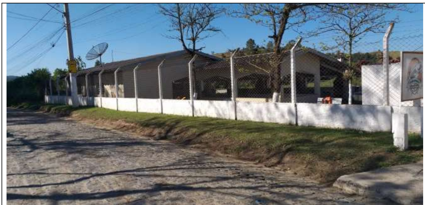
Figura 2- Vista frontal do imóvel
