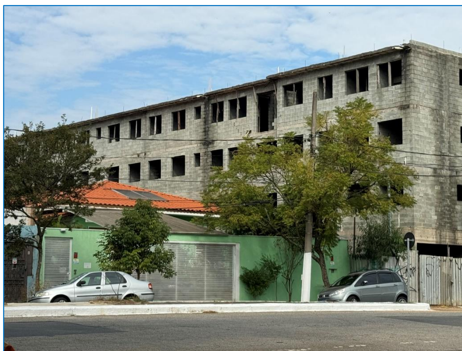
Aspectos gerais da edificação.
