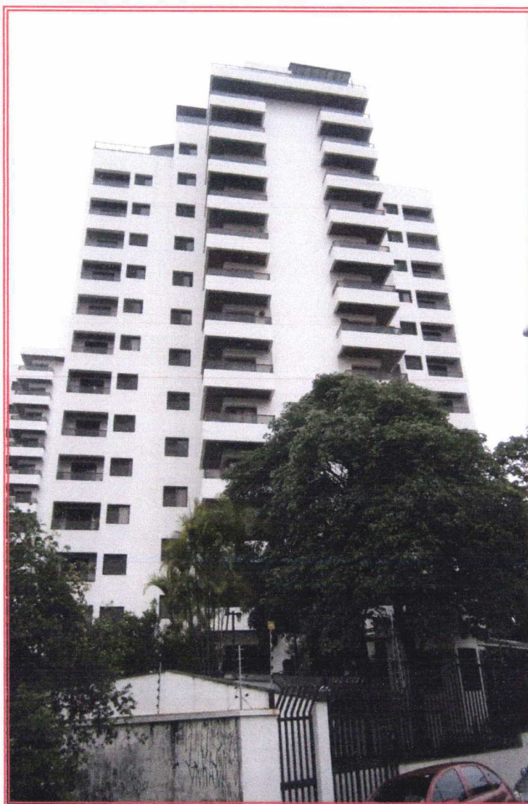
Foto nº 04: Vista geral da fachada do Bloco "A", onde se localiza o apartamento nº 12, localizado no 1º andar.
