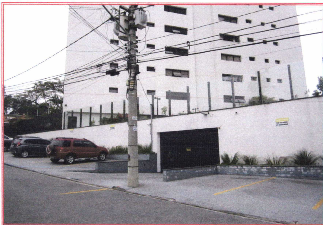
Foto 07: Vista geral das vagas externas para visitantes e acesso ao subsolo do condomínio destinado a estacionamento.
