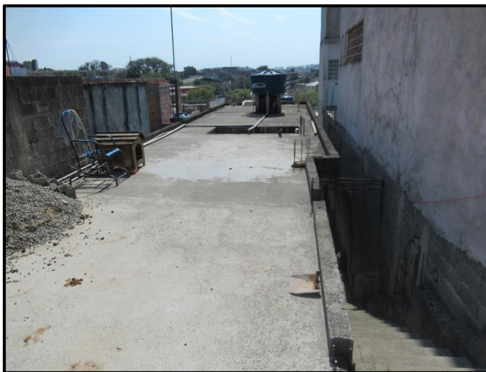
Foto 6: Vista da benfeitoria edificada abaixo do nível da Rua
