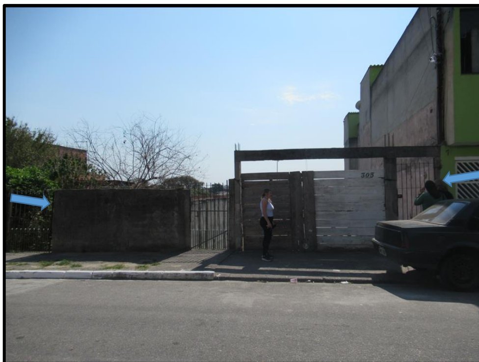
Foto 4: Vista do lote 75
