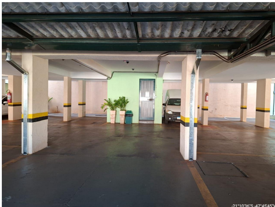
Foto 6 - Vista parcial da garagem
