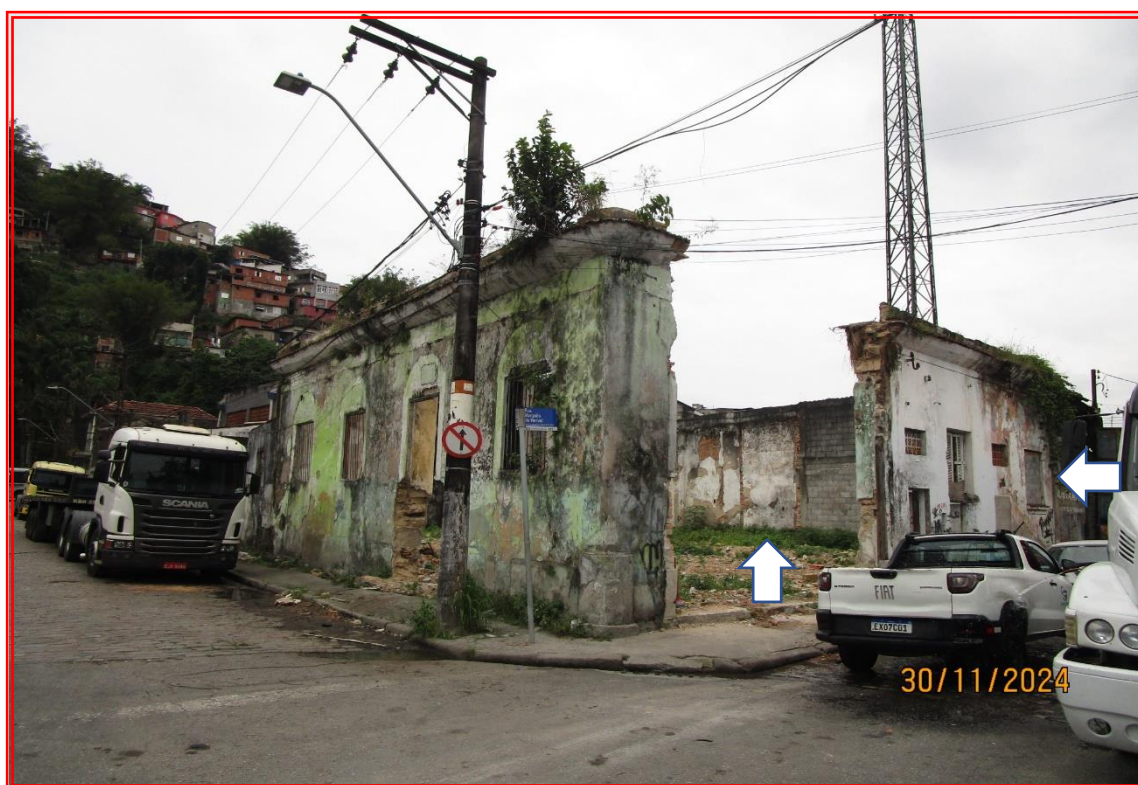
Foto nº 05: Vista parcial da quadra onde se localizam as edificações 203, 205 e 207, que foram demolidas. O imóvel objeto da avaliação de nº 207, se localiza aos fundos.
