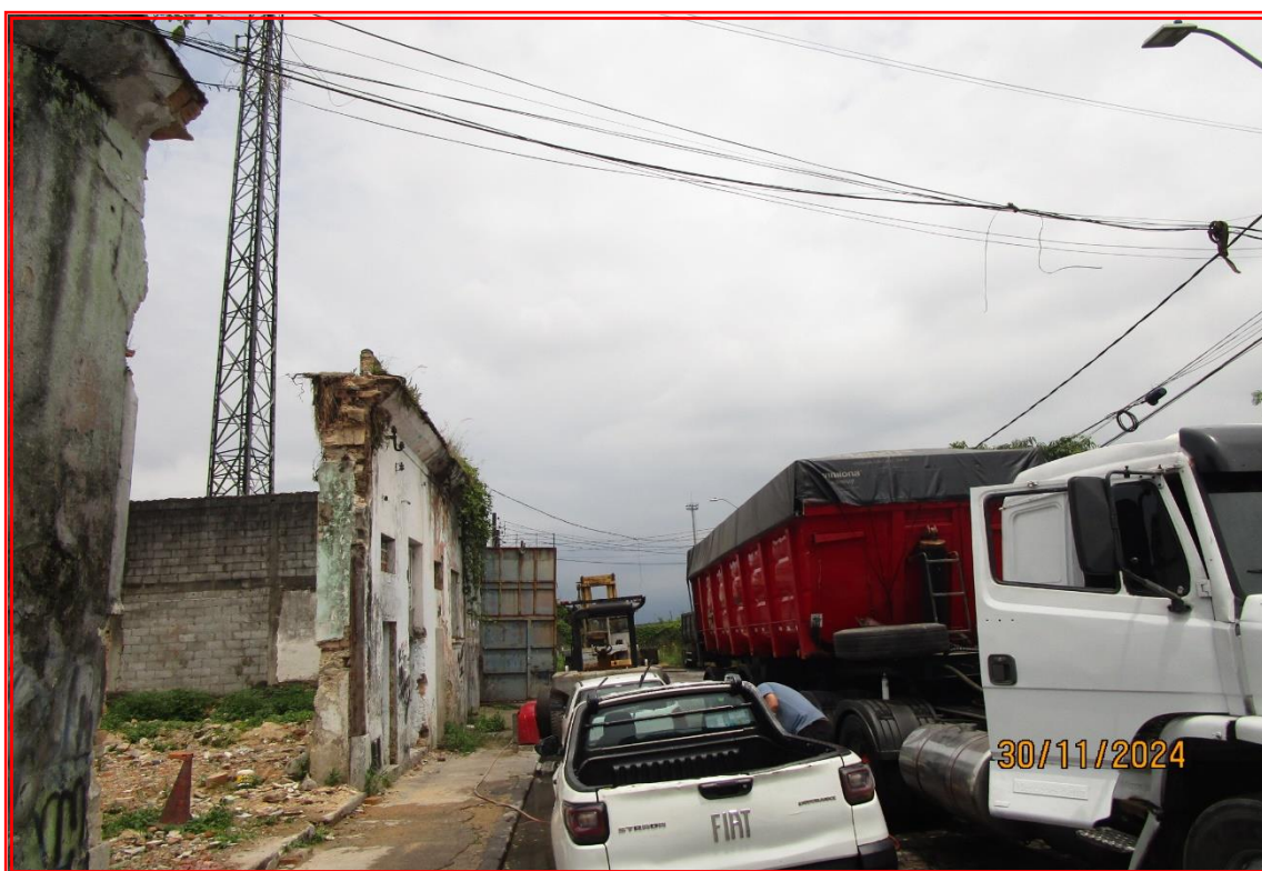
Foto nº 02: Vista parcial da Rua Marquês do Herval, tomada no sentido oposto, com detalhe para o final da via pública.
