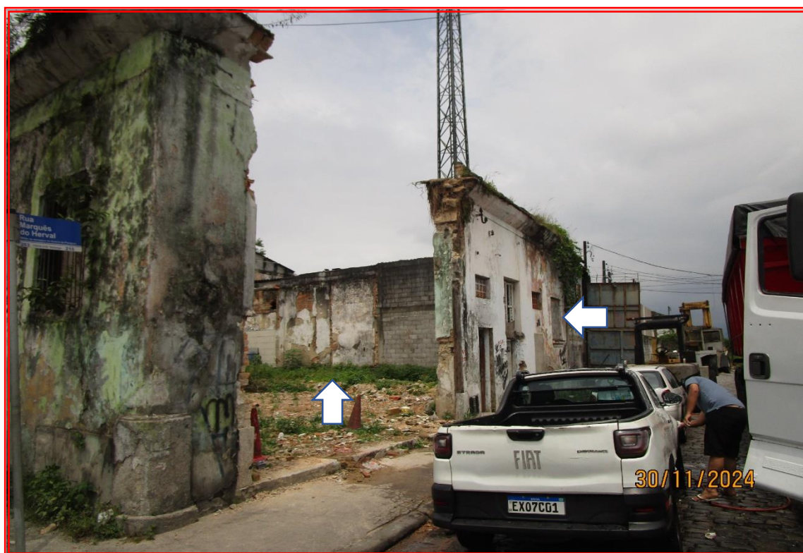
Foto nº 06: Outra vista parcial da quadra onde se localizam as edificações 203, 205 e 207, que foram demolidas. O imóvel objeto da avaliação nº 207 se localiza aos fundos.
