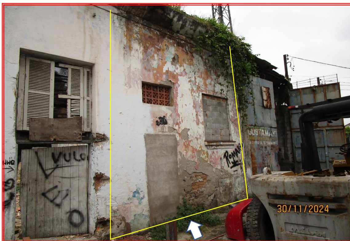
Foto nº 07: Vista parcial da fachada do imóvel avaliando.
