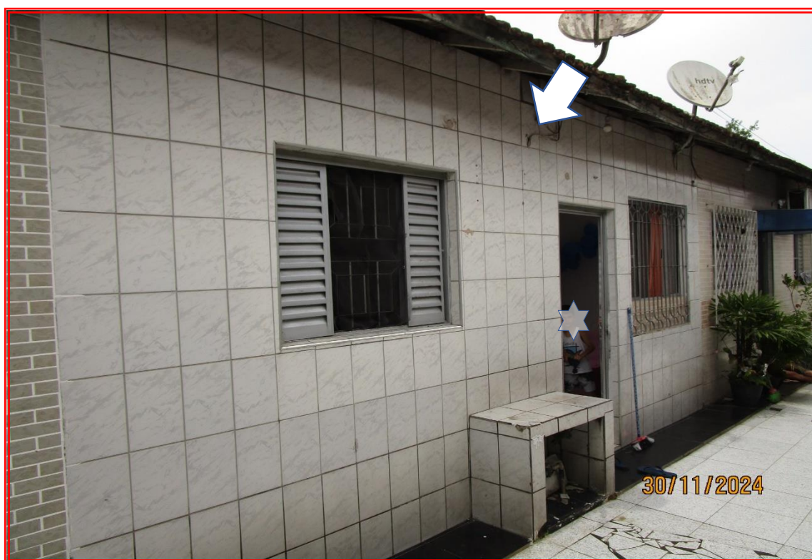
Foto nº 08: Vista geral da fachada do imóvel avaliando “ CASA 04 ”.
