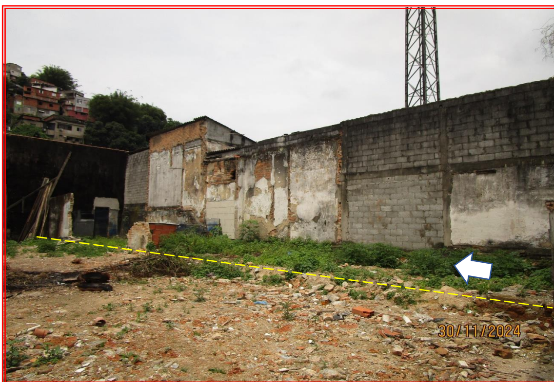
Foto nº 09: Vista geral do imóvel nº 207, objeto da avaliação, descrito na matrícula nº 12.606.
