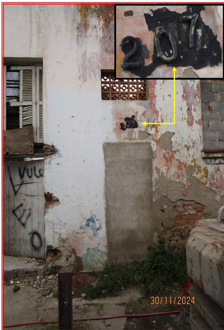
Foto nº 08: Detalhe para o nº 207 de identificação predial do imóvel avaliando.
