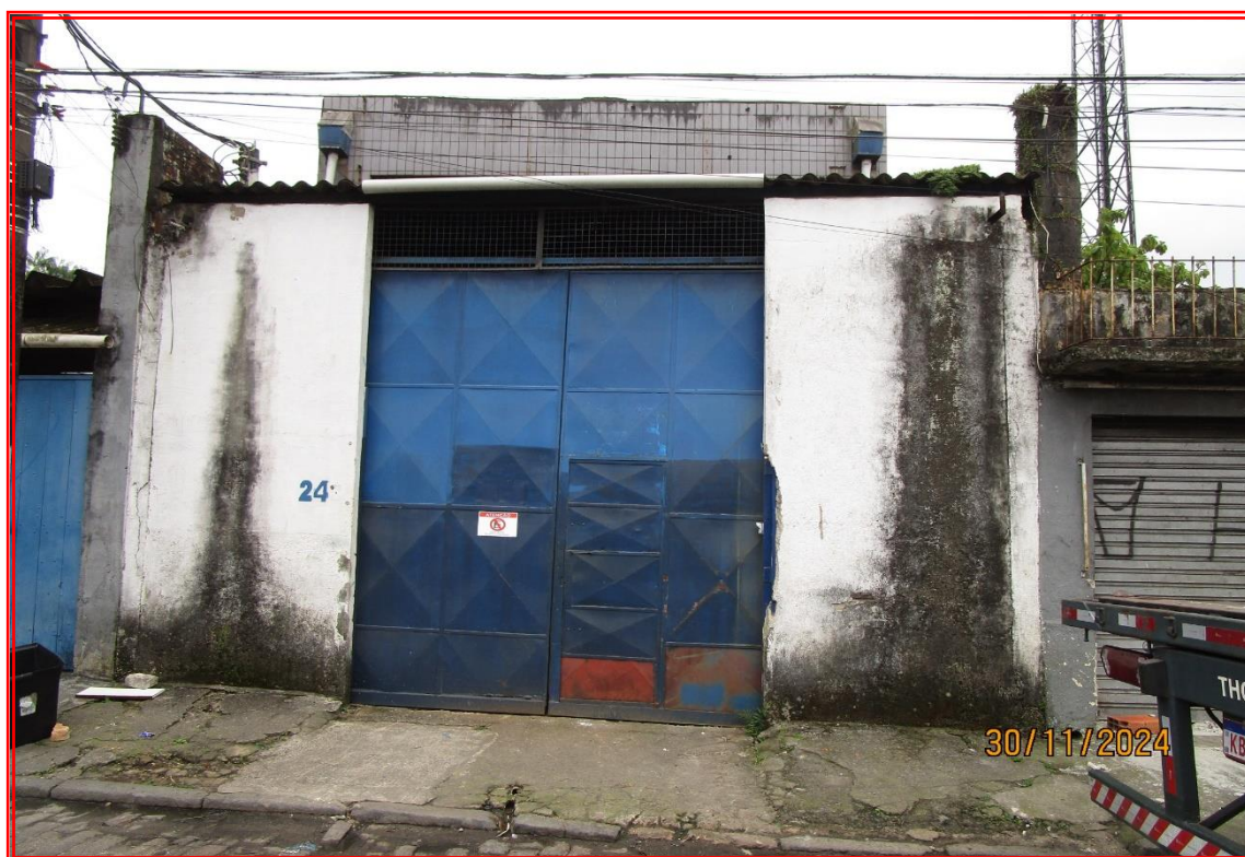
Foto nº 04: Vista geral da fachada do imóvel nº 24 da Rua Travessa João Cardoso, cuja sua lateral direita faz divisa com os fundos do imóvel avaliando conforme planta quadra digital de loteamento.
