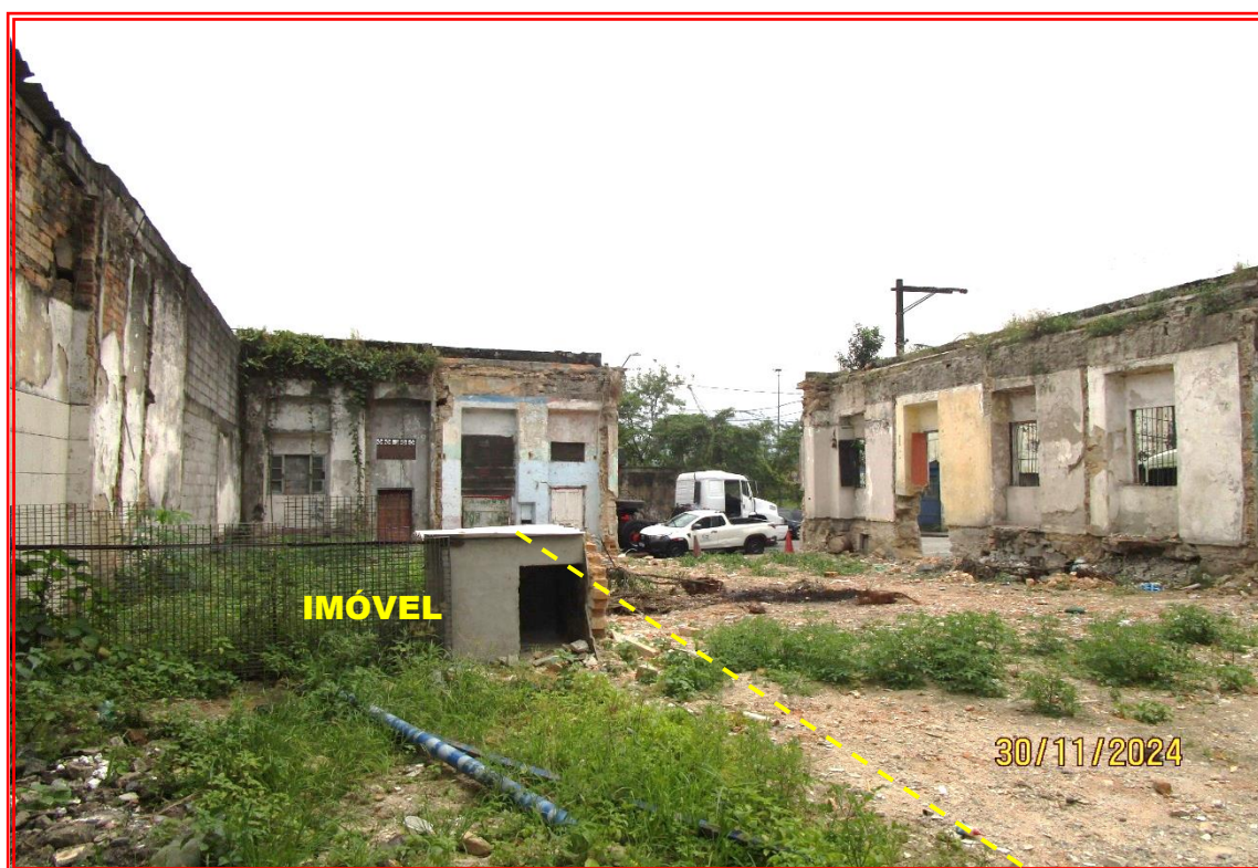
Foto nº 11: Vista geral do imóvel nº 207, objeto da avaliação. Detalhe para os imóveis 205 e 203 que também foram demolidos.
