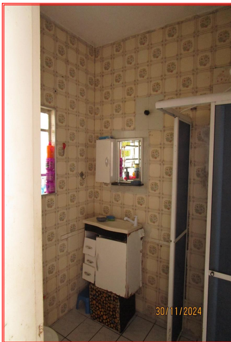
Foto nº 11: Vista parcial do banheiro.
