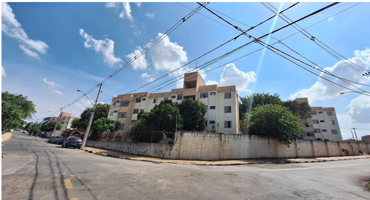
Foto no. 1- Vista do Condomínio.
