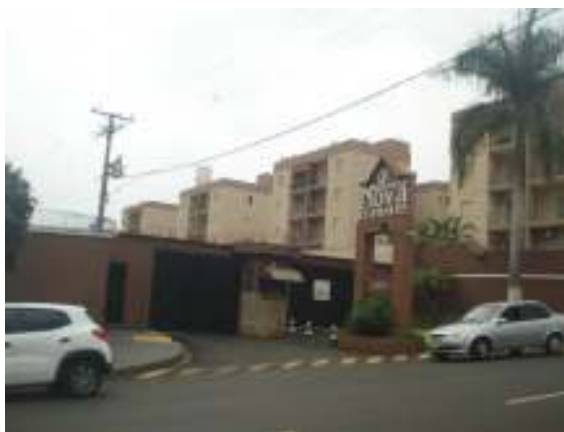
FOTO 01 – Vista da portaria do Condomínio Morada Nova Planalto I.
