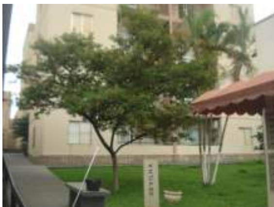
FOTO 02 – Vista do Bloco 4 do Condomínio Morada Nova Planalto I.
