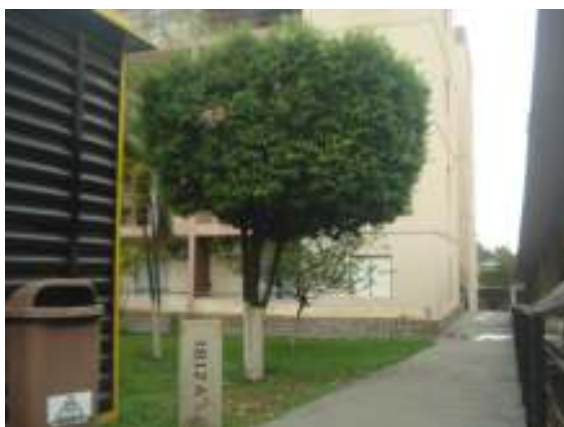
FOTO 03 – Vista do Bloco 8 do Condomínio Morada Nova Planalto I.
