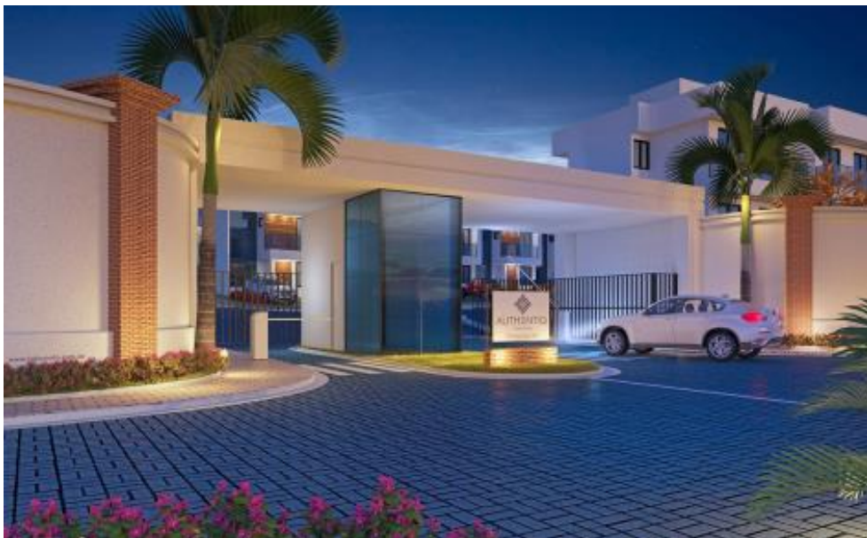
Foto 02 - Fachada do condomínio
