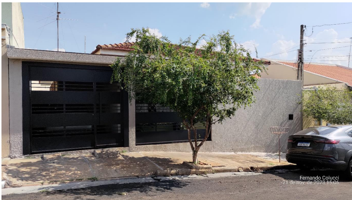
Figura 6 - Fachada do imóvel.
