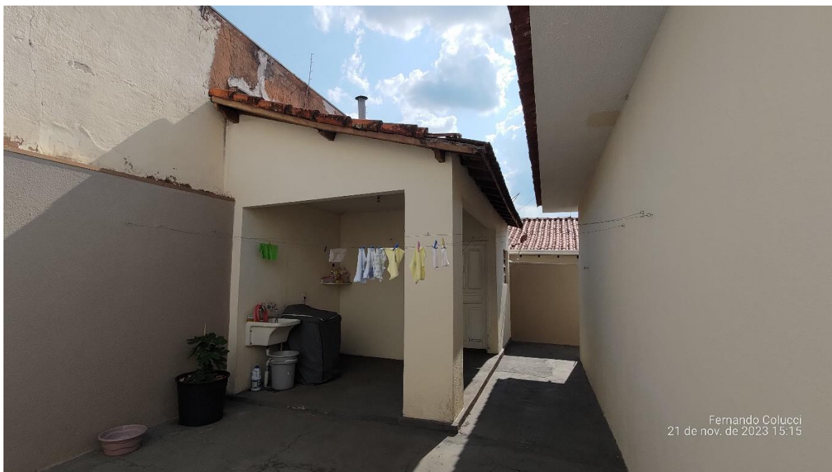
Figura 26 - Vista externa do quarto
