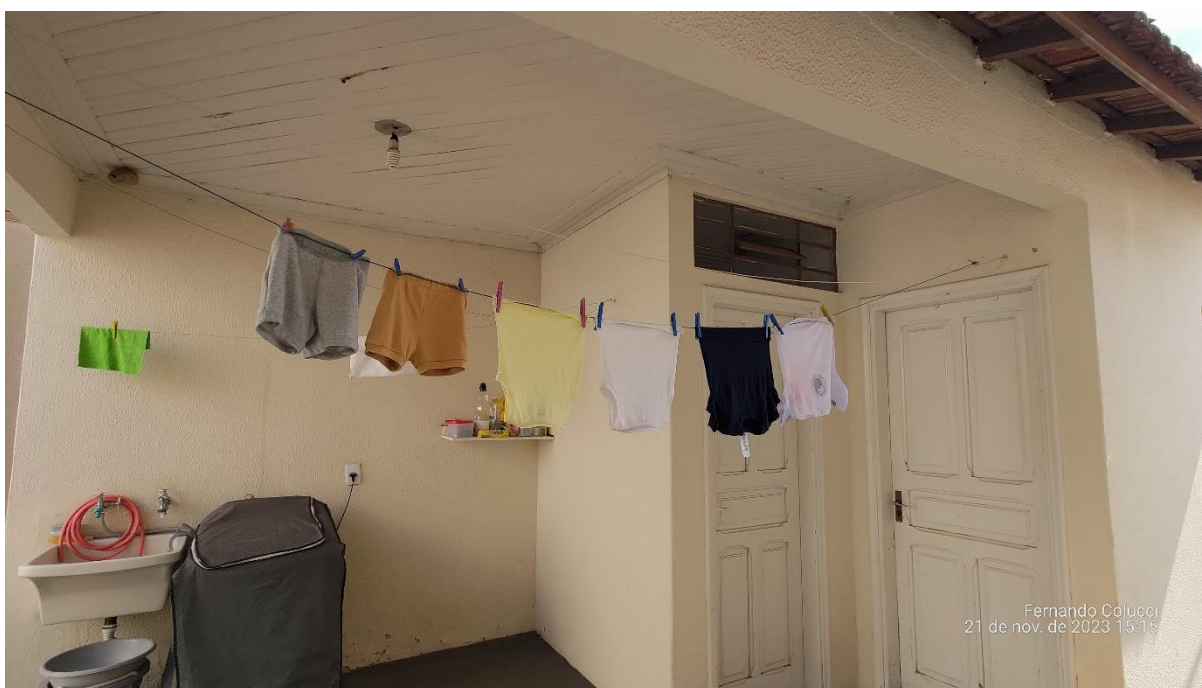
Figura 27 - Vista externa do quarto
