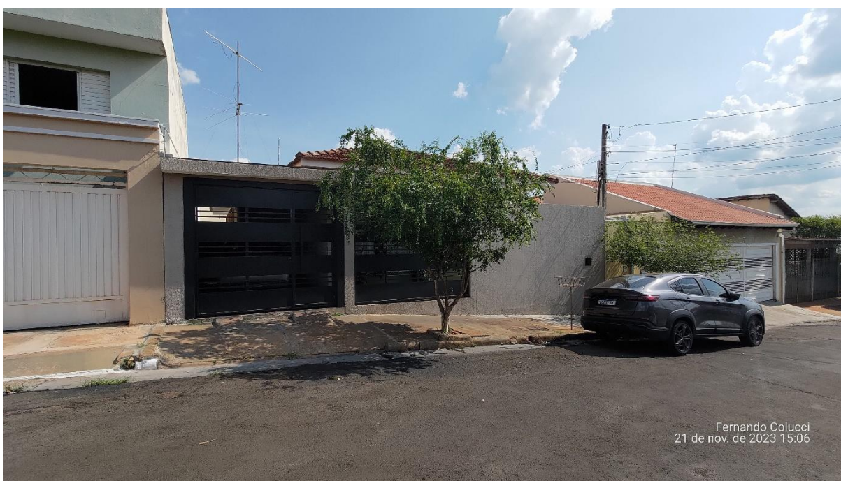
Figura 7 - Fachada do imóvel - Visão ampla
