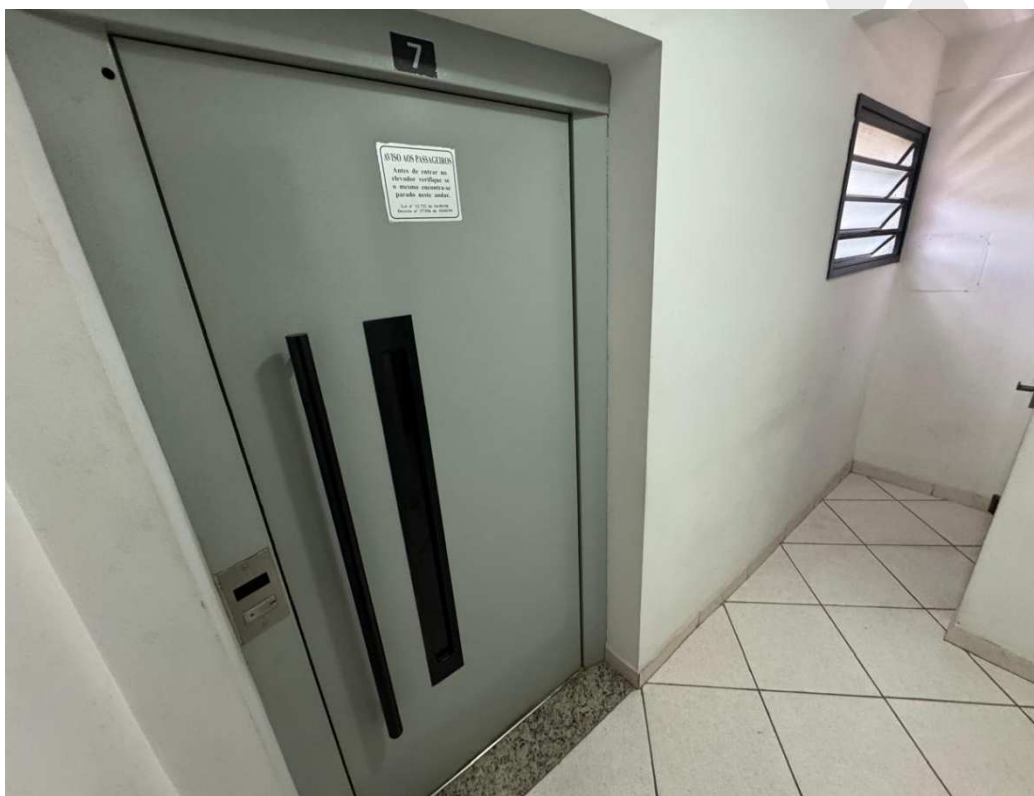
Fotografia 19 – Aspecto do hall de elevador.
