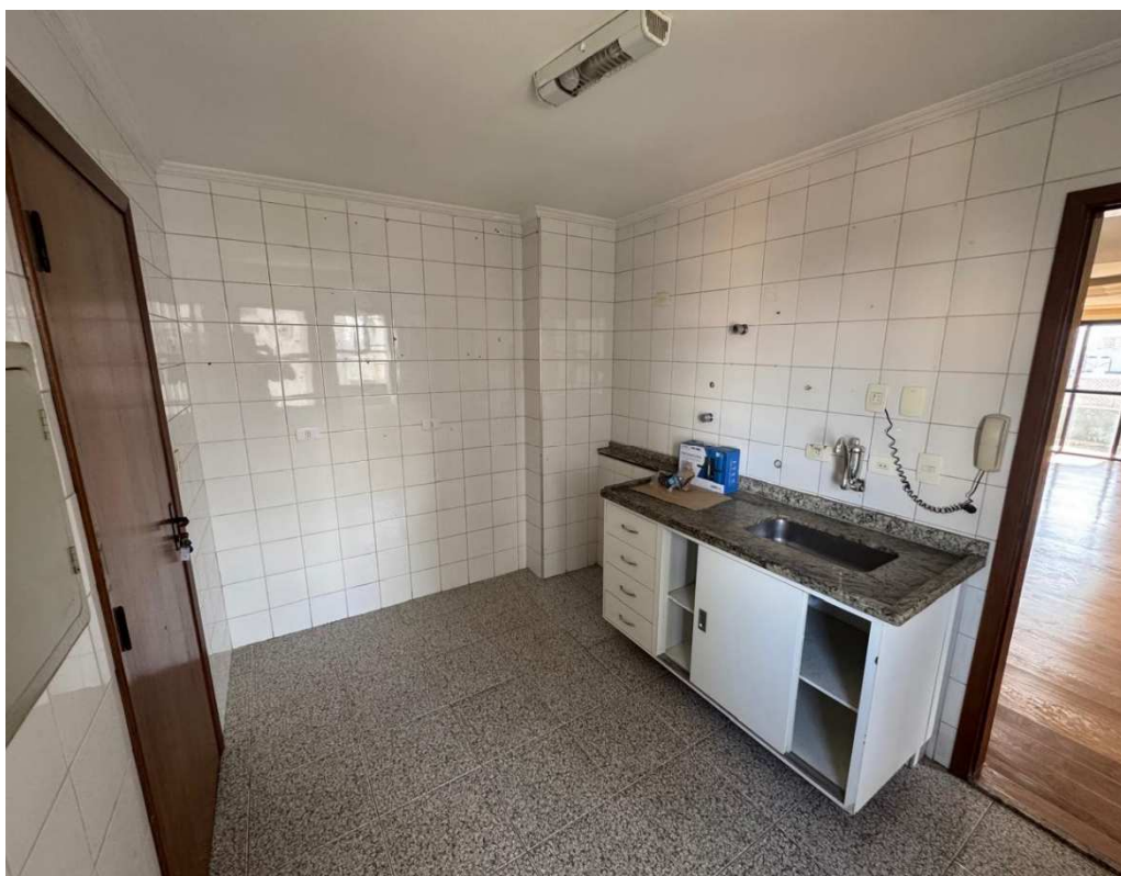
Fotografia 18 – Aspecto interno da Unidade nº 71.
