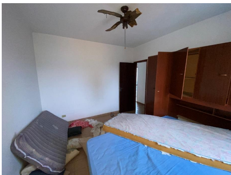
Imagem 36 - Vista do dormitório do apartamento avaliando.
