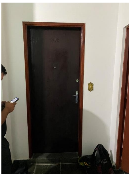
Imagem 37 - Vista da porta devidamente trancada e sem danos após a realização da vistoria.
