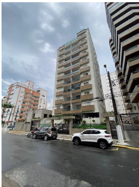
Imagem 1 - Vista da fachada do condomínio.
