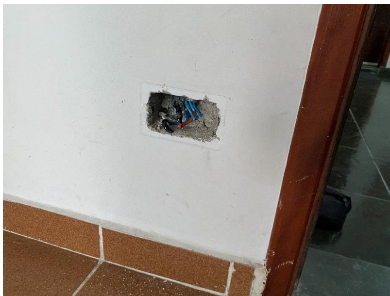
Imagem 17 - Vista de tomadas removidas das paredes da sala.
