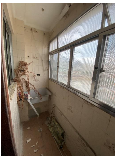
Imagem 22 - Vista da área de serviço do apartamento avaliando.
