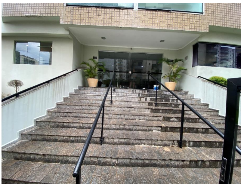
Imagem 3 - Vista do hall de entrada do condomínio.
