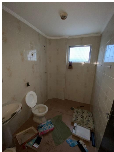
Imagem 30 - Vista do banheiro do apartamento avaliando.
