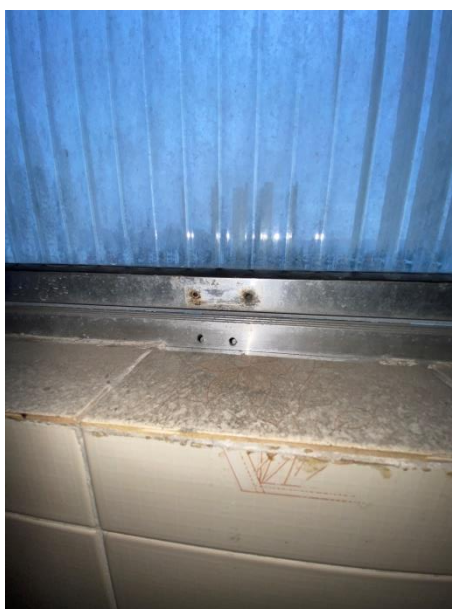
Imagem 32 - vista de alça da janela do banheiro removida.
