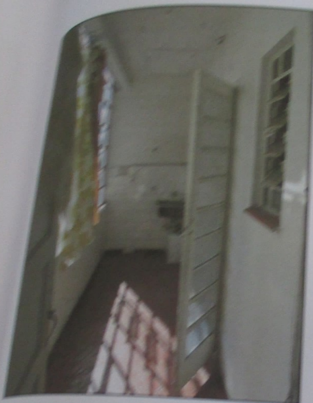
Detalhe da casa de serviço.
