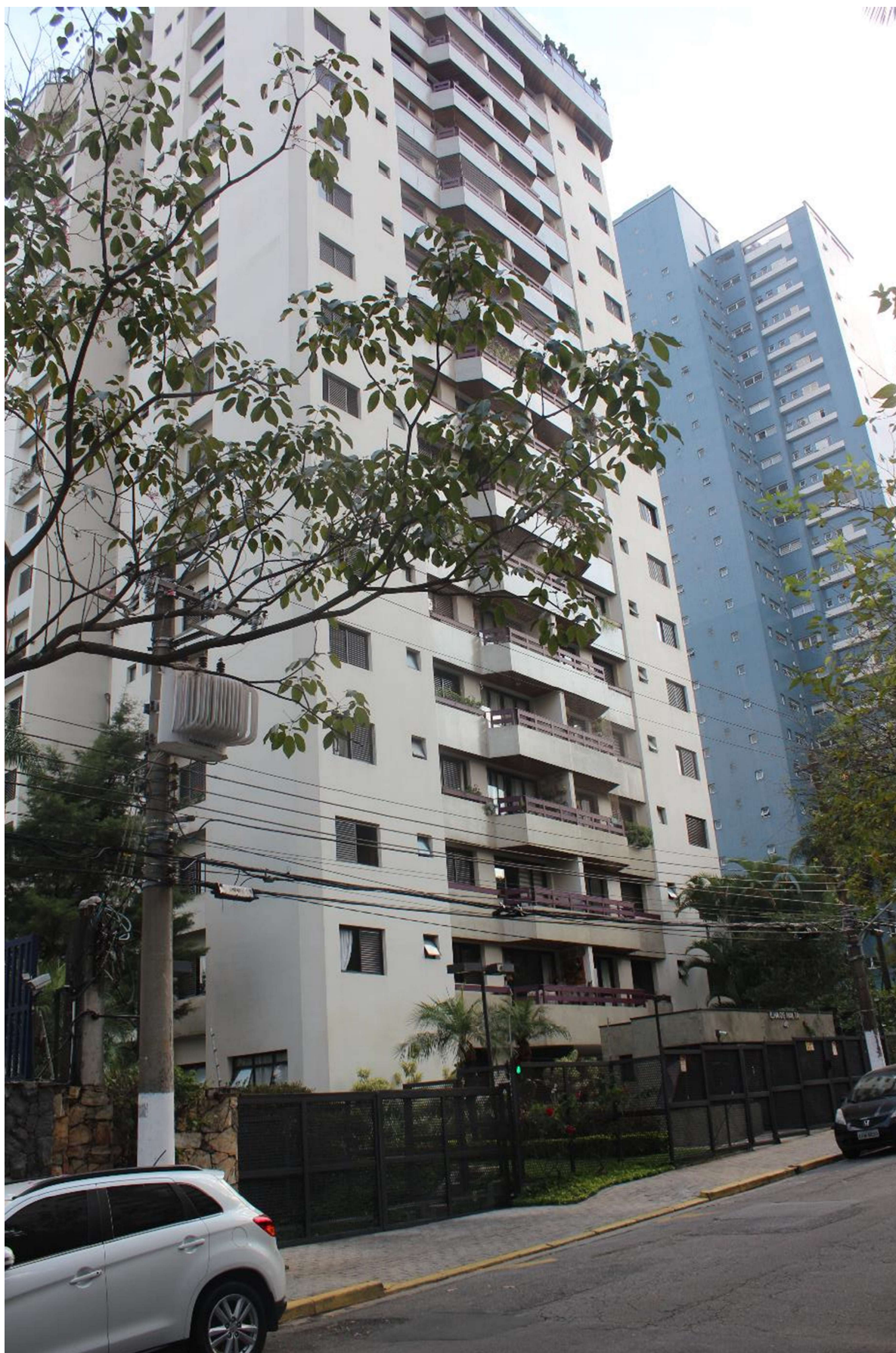
Condomínio Edifício Ilha de Malta – Fachada
