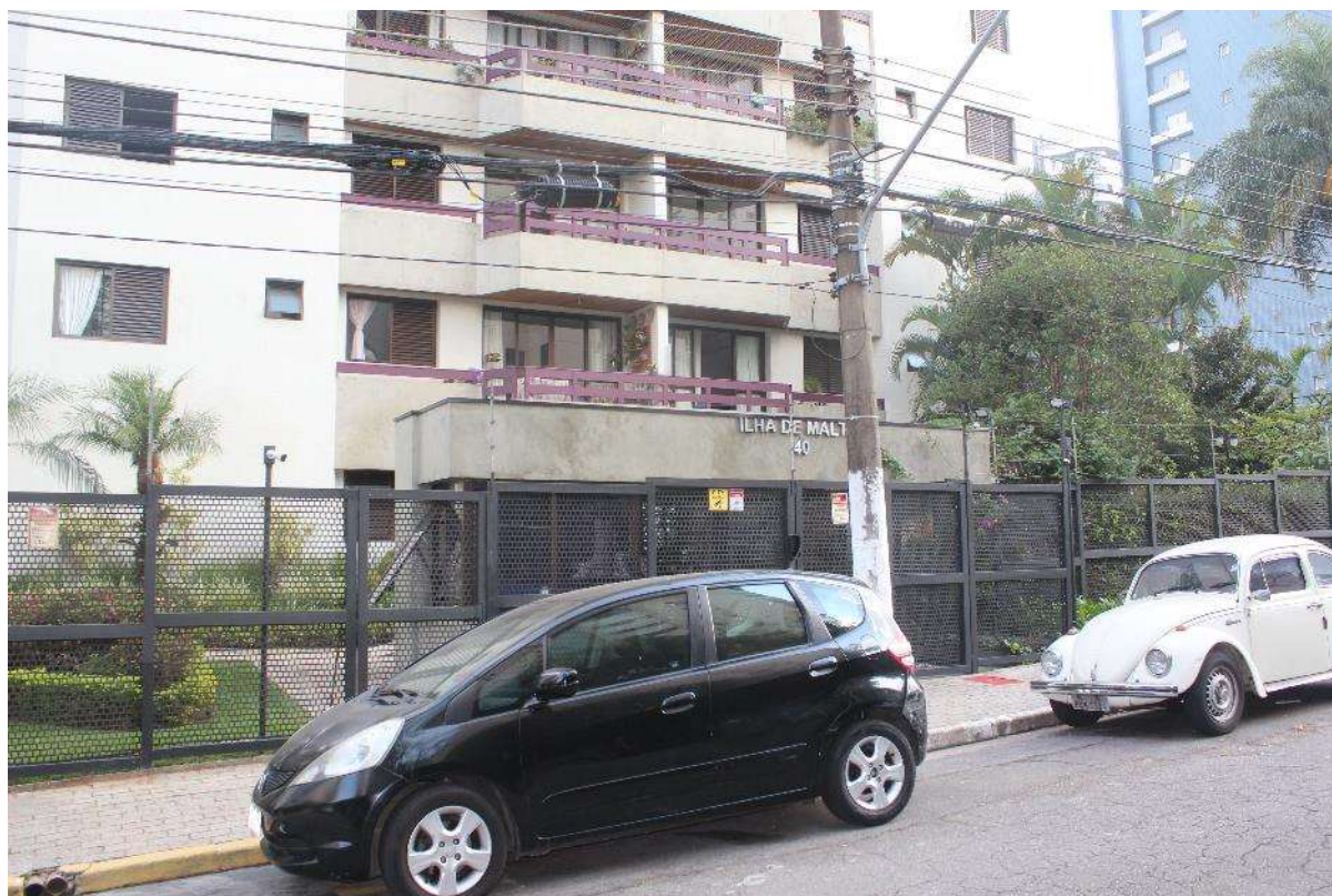
Condomínio Edifício Ilha de Malta – Fachada
