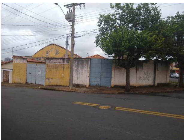
Figura 3 - Vista frontal do imóvel
