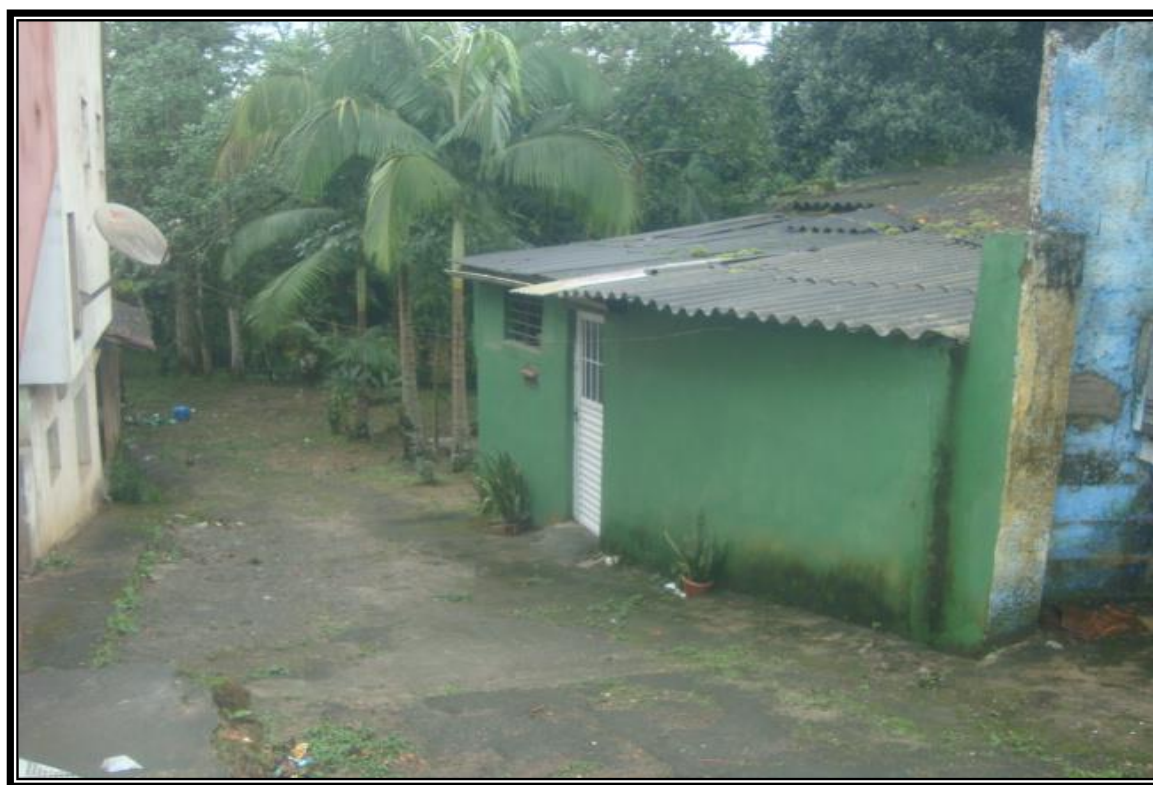
Foto nº 4: Vista da frente do imóvel voltada para a passagem de servidão e próximo a cabeceira da ponte, retratada na foto 01 .
