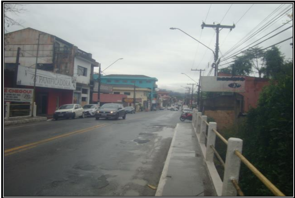
Foto nº 1: Vista da Avenida Doutor Carlos Botelho. O observador encontra-se na ponte sobre o Rio Pariquera-Açú e defronte ao imóvel avaliando olhando em direção ao centro da cidade.
