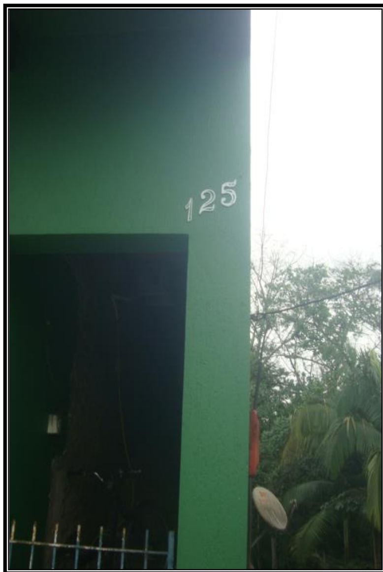
Foto nº 7: Vista em detalhe do nº 125.
