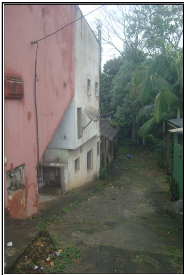
Foto nº 5: Vista do acesso para o interior do imóvel avaliando.
