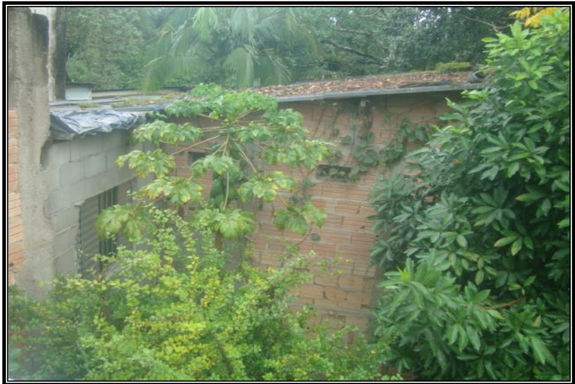
Foto nº 3: Vista dos da edificação existente no imóvel e próximo a margem do Rio Pariquera-Açú.
