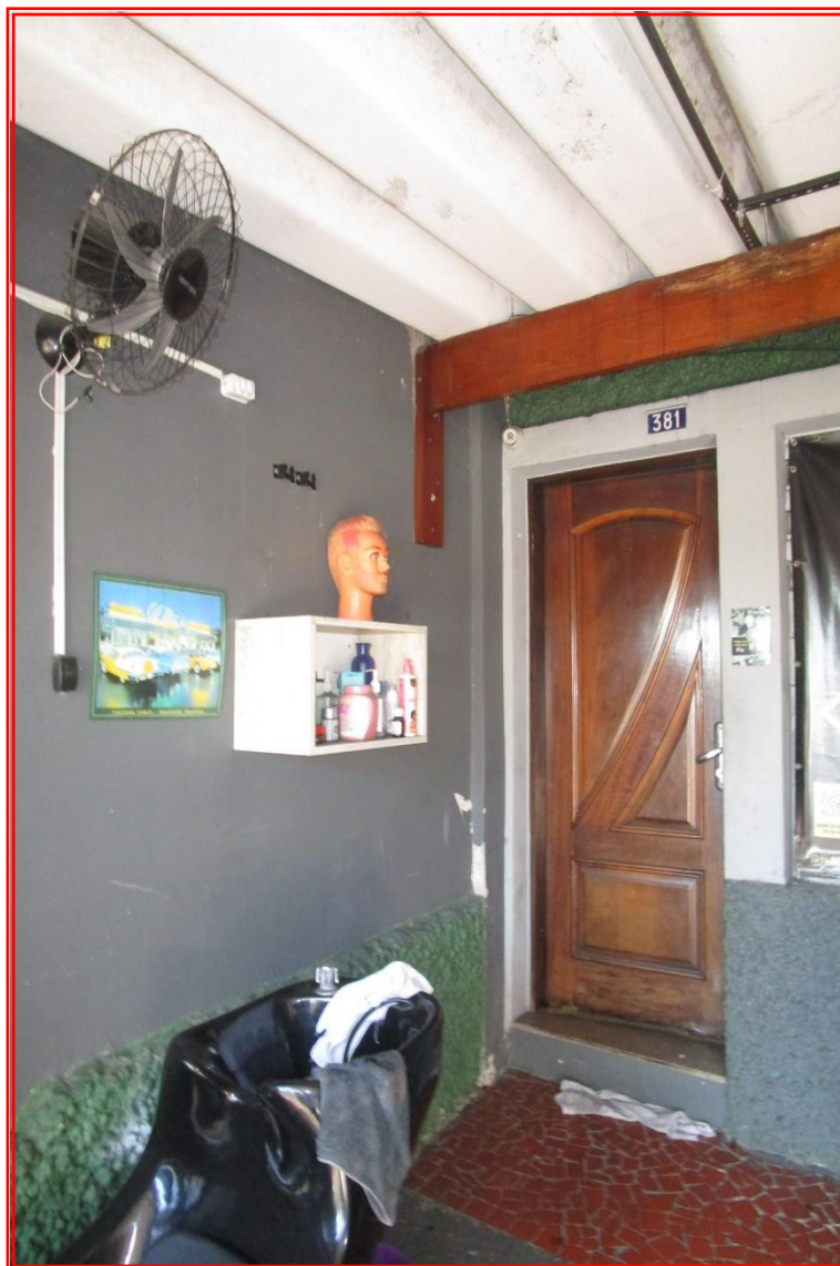
Foto nº 03: Vista parcial da garagem coberta.
