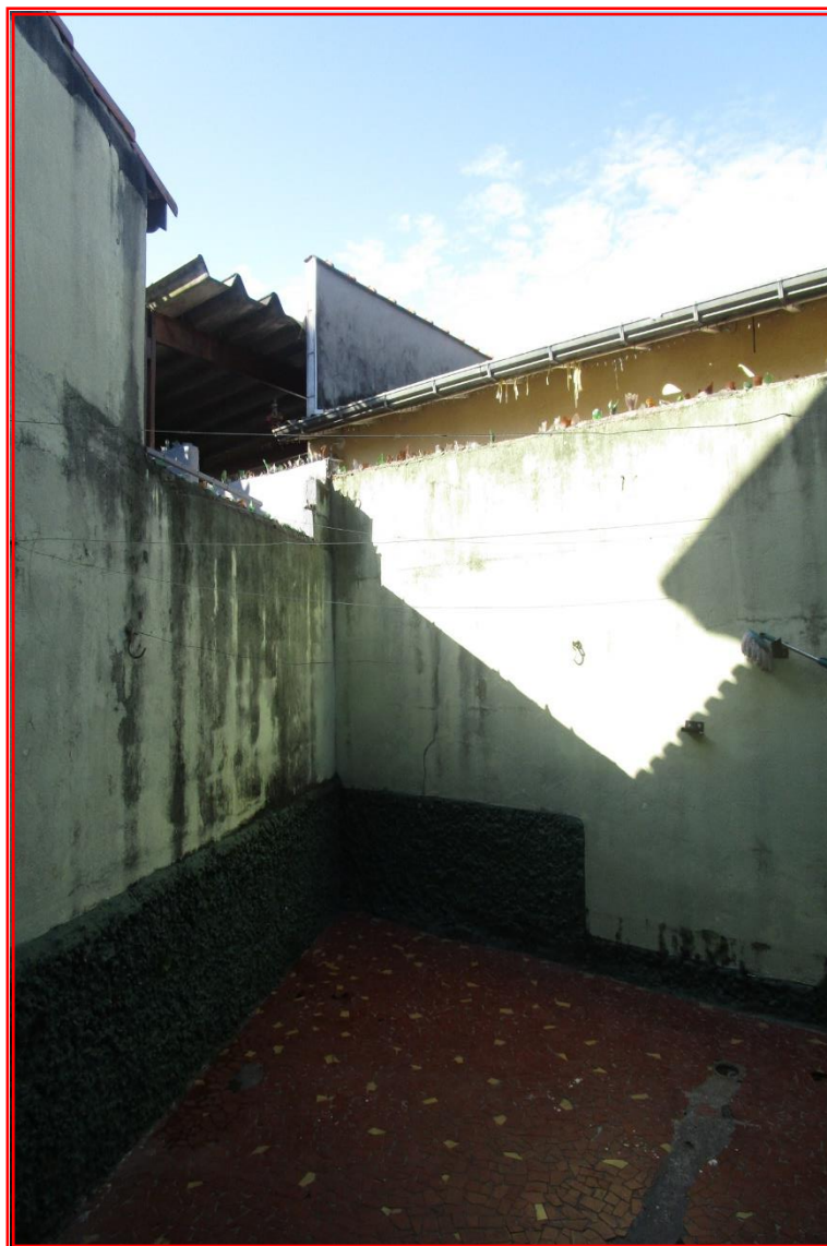
Foto nº 06: Vista parcial da área descoberta dos fundos.
