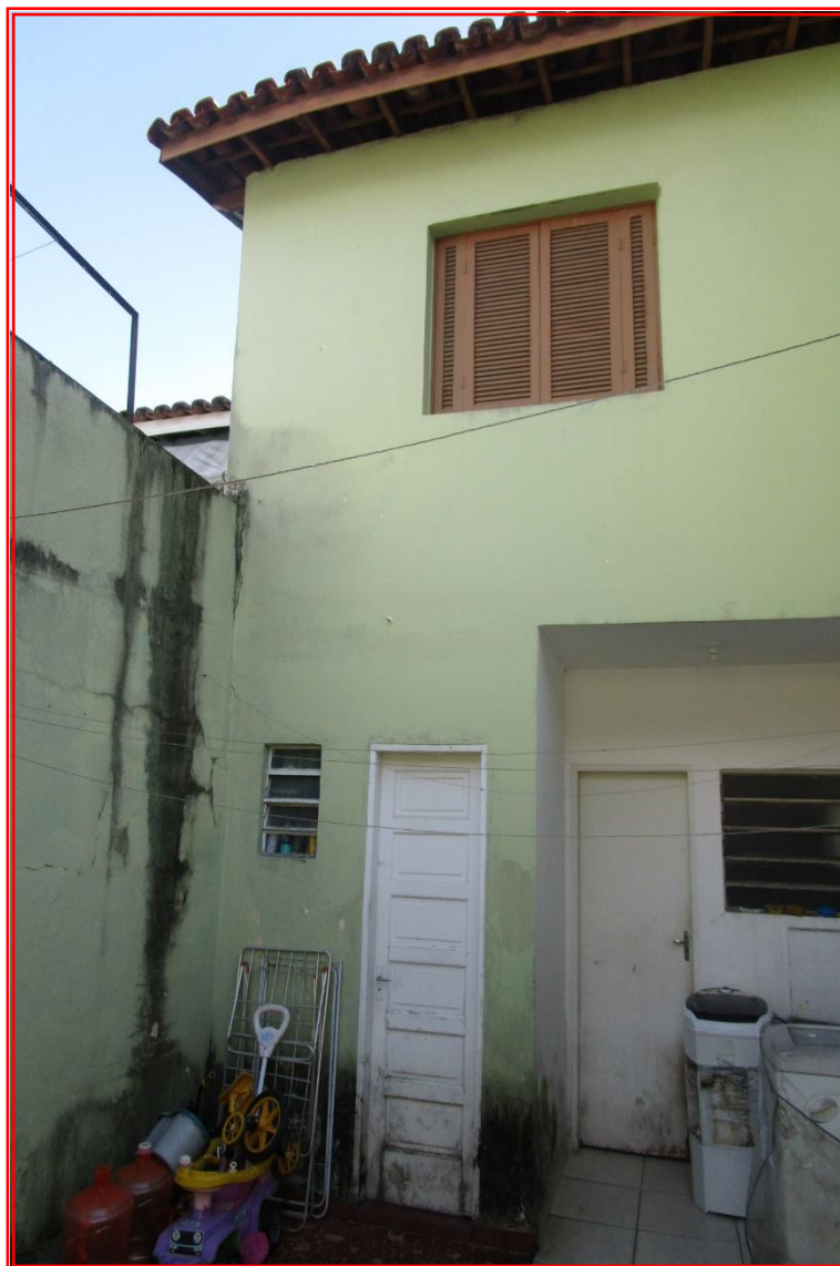
Foto nº 07: Vista parcial da fachada posterior e banheiro externo.
