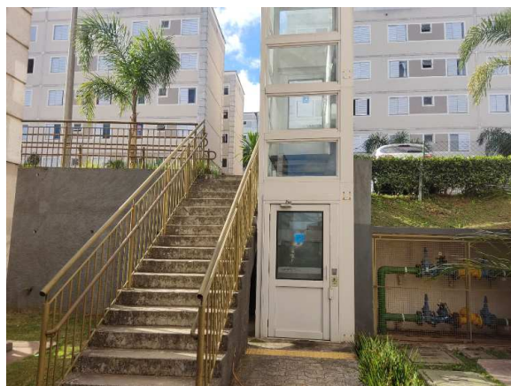
Elevador de acesso
