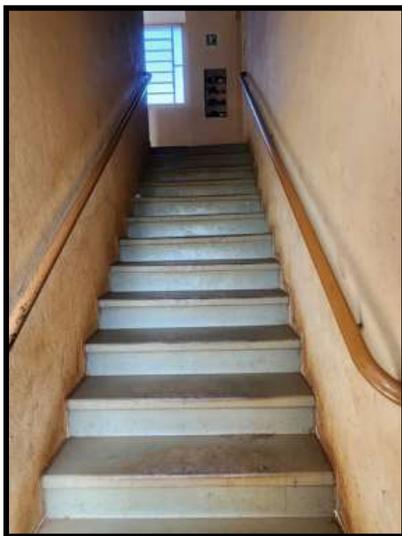
ESCADARIAS DE ACESSO AOS PAVIMENTOS SUPERIORES
