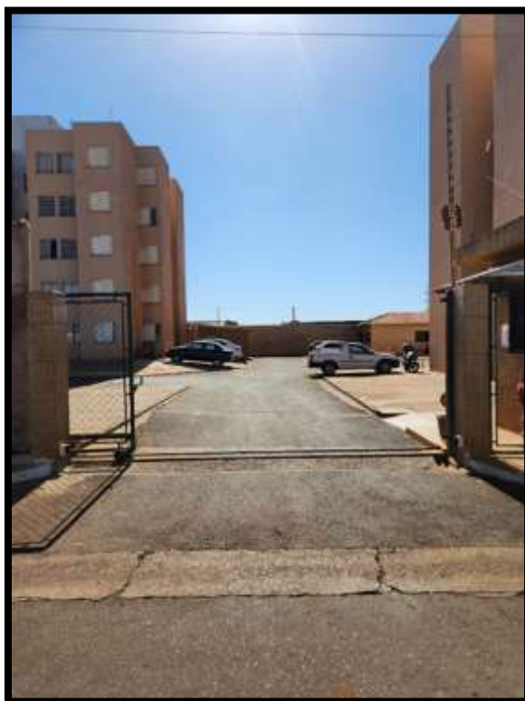
ENTRADA DE VEÍCULOS
