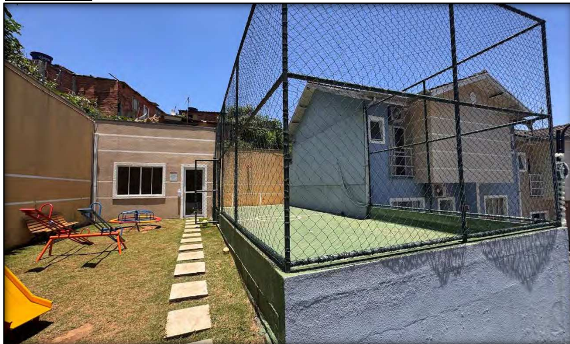
VISTA INTERNA DO CONDOMÍNIO DO IMÓVEL AVALIADO
