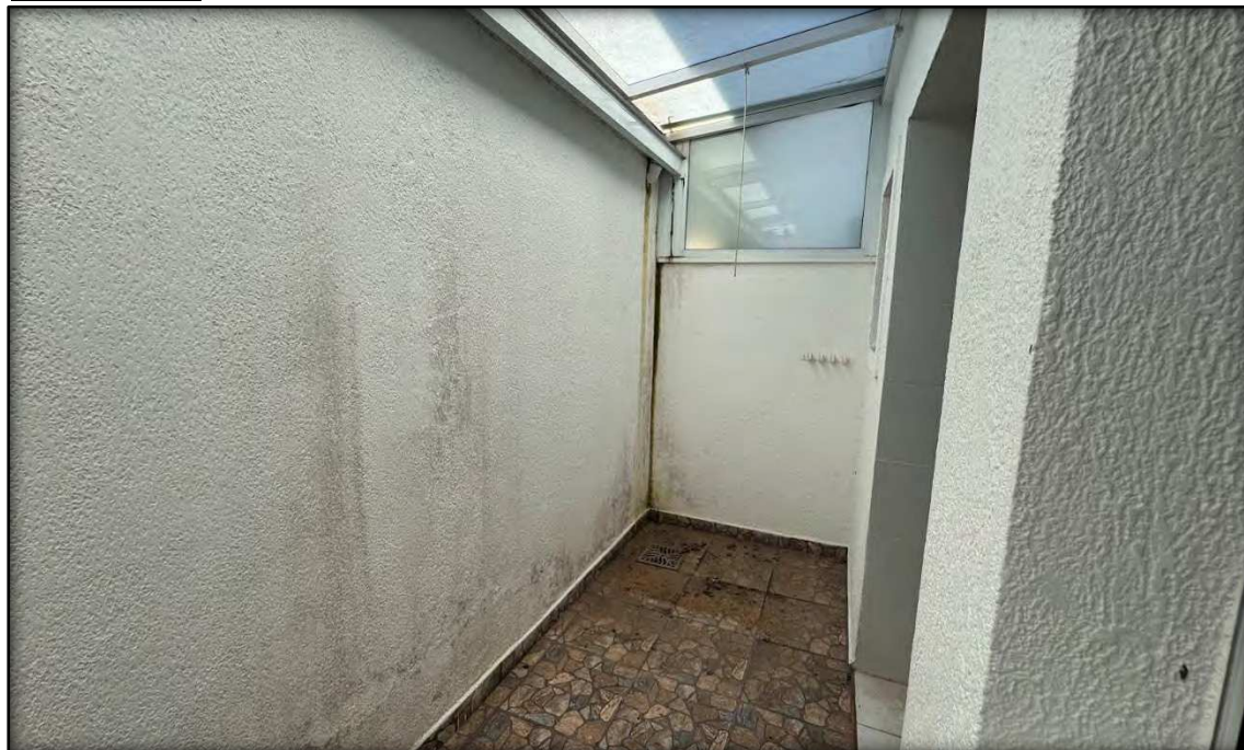
VISTA INTERNA DO IMÓVEL AVALIADO
