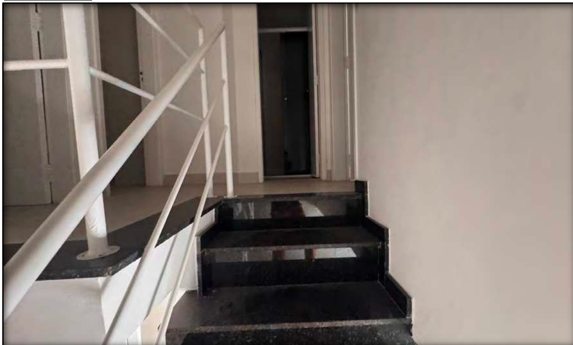
VISTA INTERNA DO IMÓVEL AVALIADO
