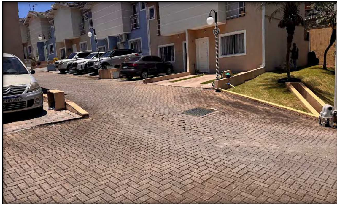
VISTA INTERNA DO CONDOMÍNIO DO IMÓVEL AVALIADO
