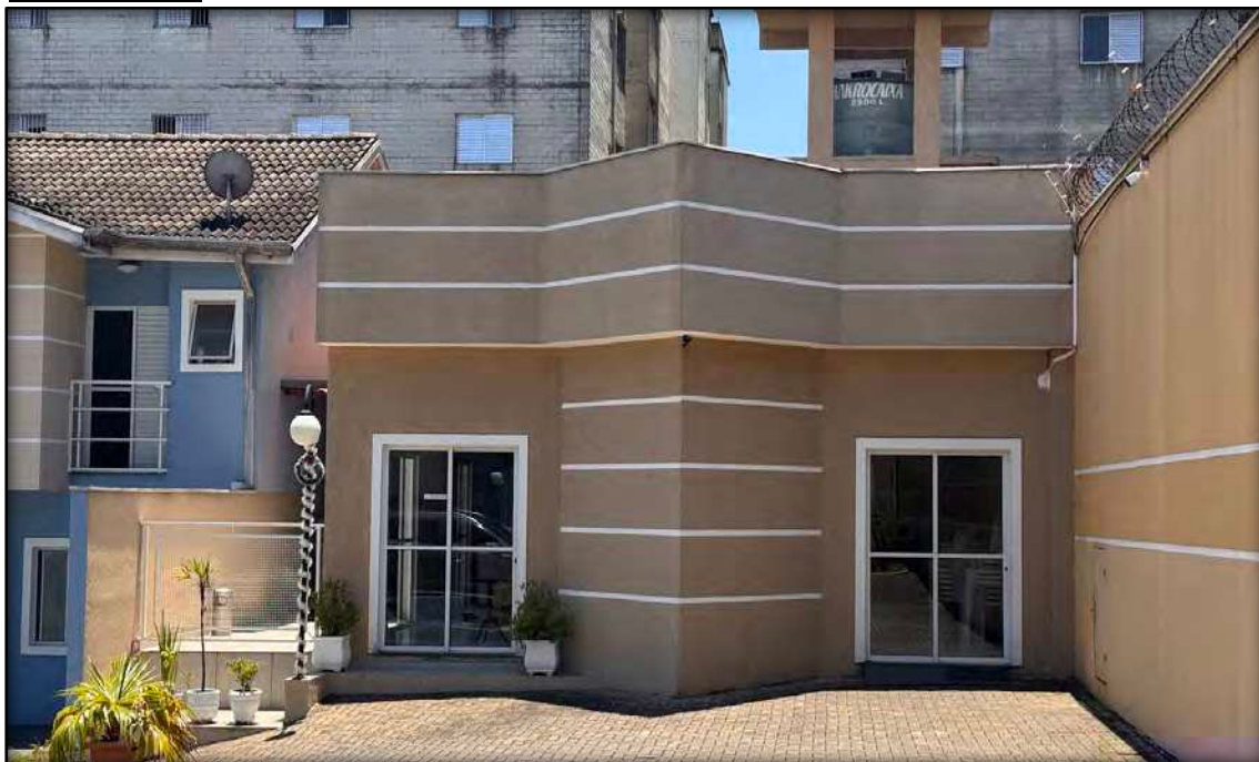
VISTA INTERNA DO CONDOMÍNIO DO IMÓVEL AVALIADO
