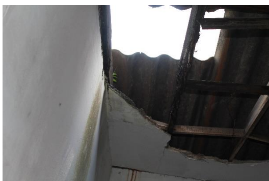
Foto 22 - telhado do quarto ao lado da sala
