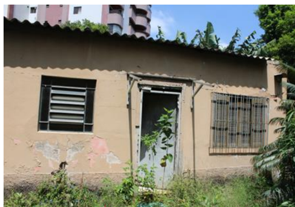
Foto 12 – acesso pela porta da cozinha
