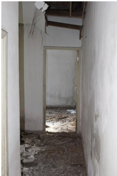
Foto 17 acesso a sala, quarto e banheiro
