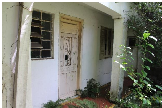
Foto 7 – Casa nos fundos do terreno
