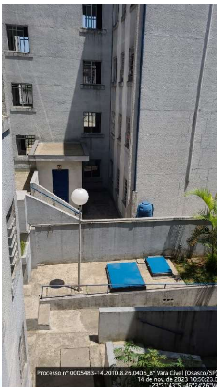
foto 030 – Vista do hall de entrada do imóvel
