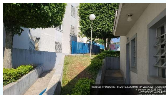
foto 006 – Acesso aos edifícios do condomínio
