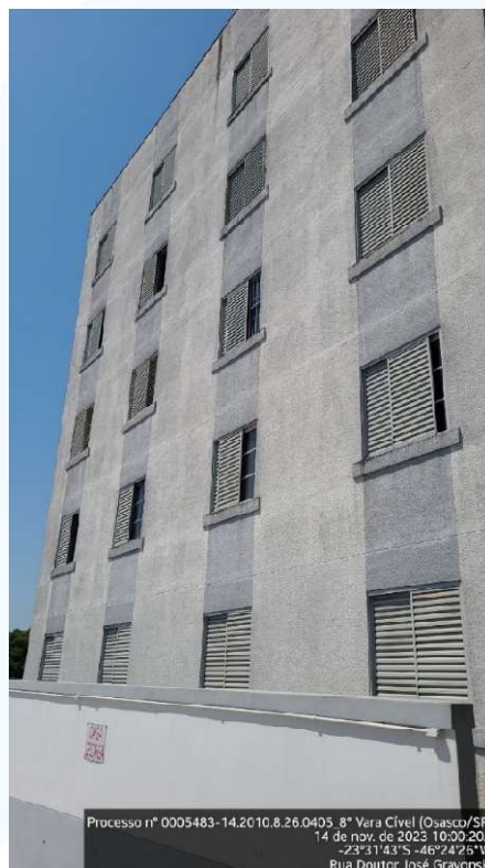
foto 031 – Fachada padrão dos edifícios
