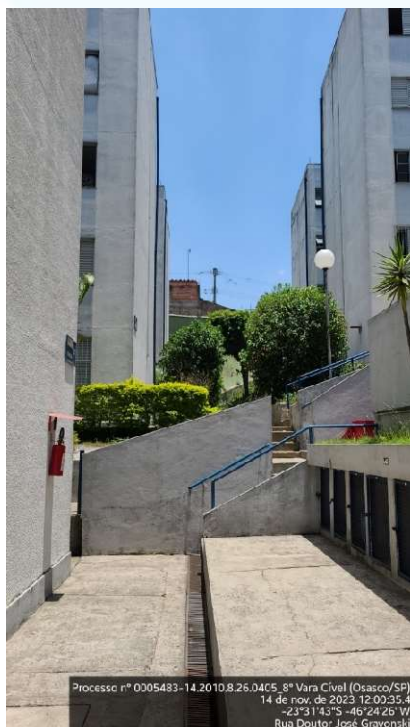
foto 032 – Acesso ao Bloco "F"
