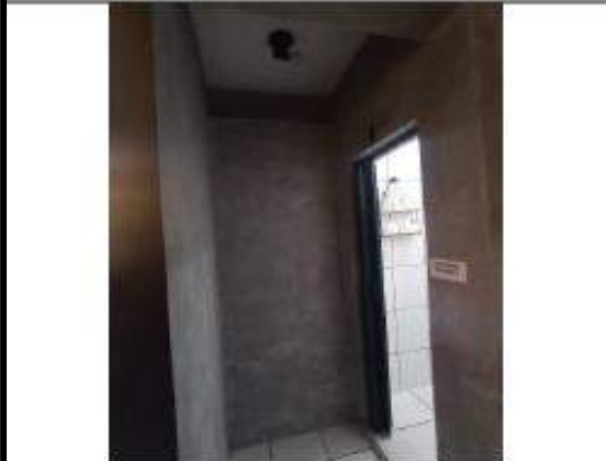
11 - OUTRA DA ÁREA COMUM DE ACESSO AOS W.C'S.
