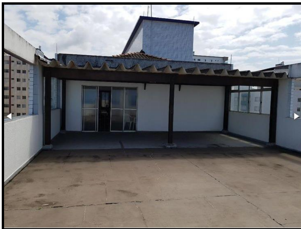
Local: terraço descoberto
