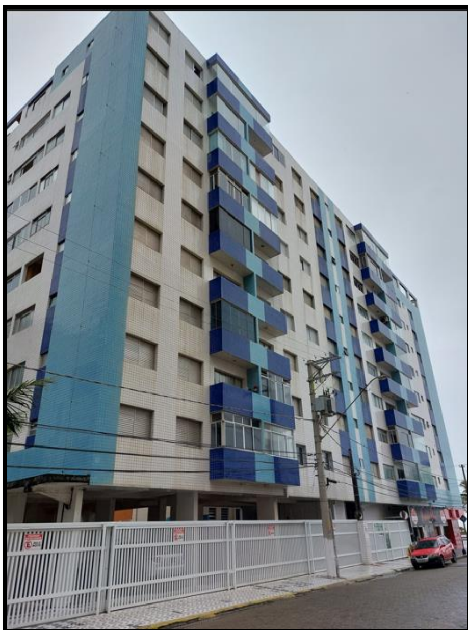
Vista frontal do Edifício
