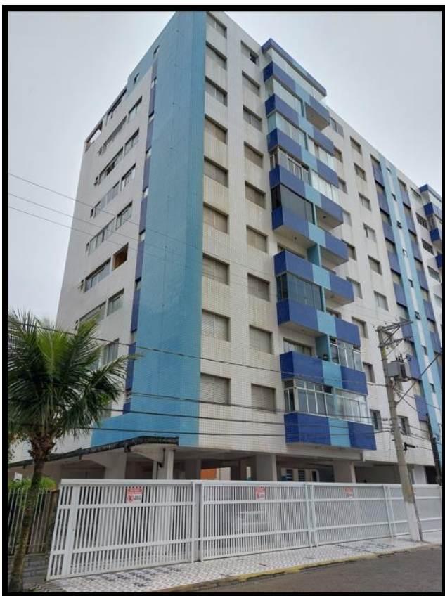
Vista Lateral do Edifício Mariana
