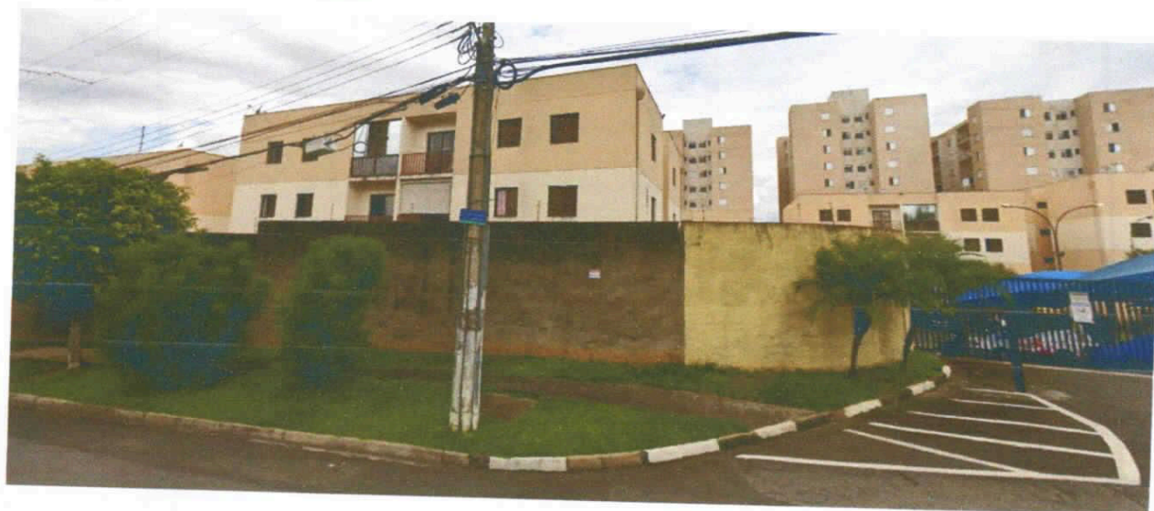
FOTO EXTERNA DO CONDOMINIO
