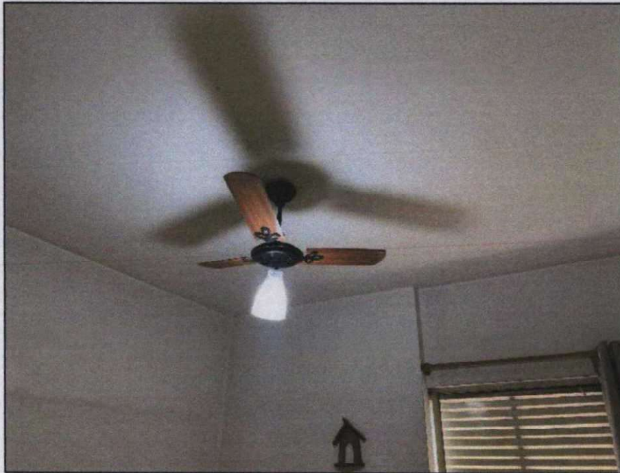
Foto 29. Detalhe do teto do quarto.
