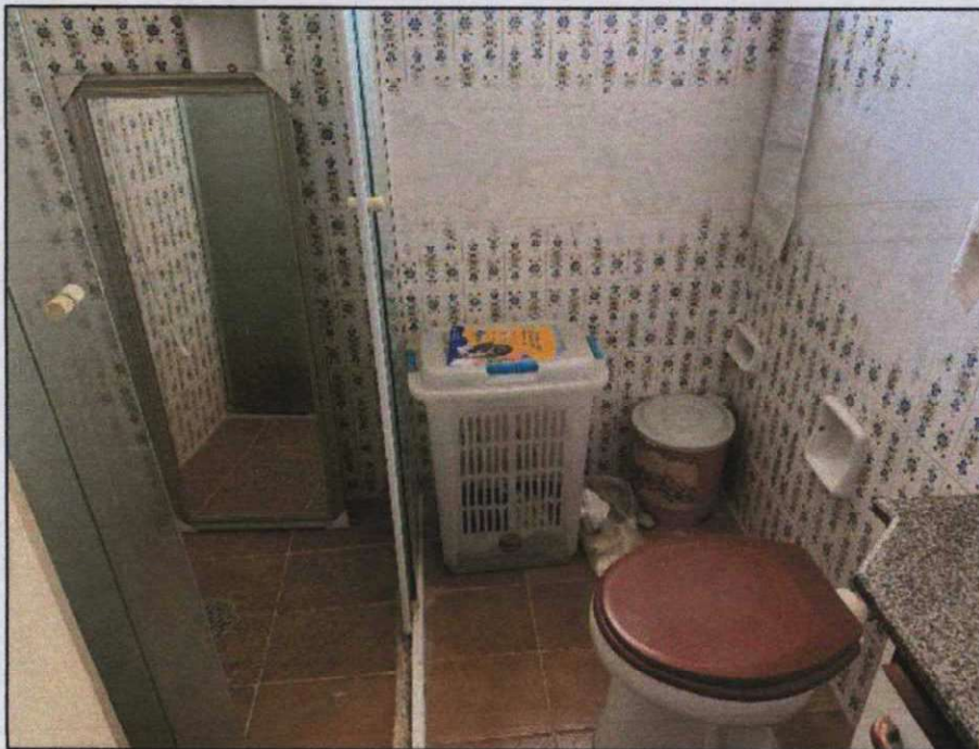
Foto 28. Detalhe do piso do banheiro.
