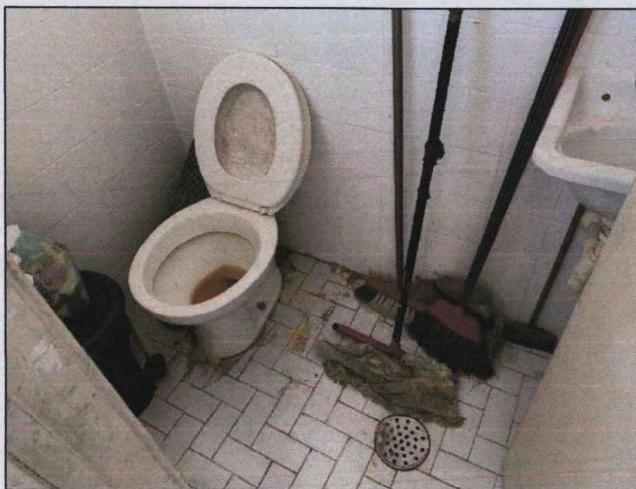
Foto 18. Detalhe do piso do banheiro de serviço.
