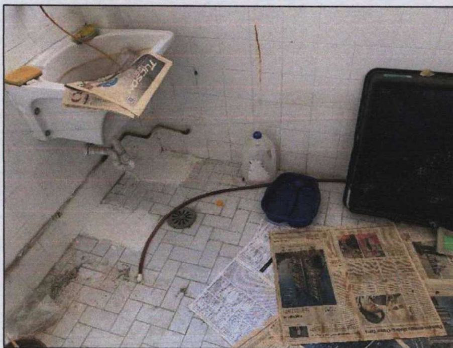
Foto 12. Detalhe do piso da área de serviço.
