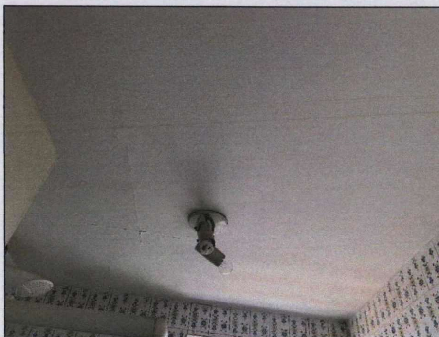
Foto 26. Detalhe do teto do banheiro.
