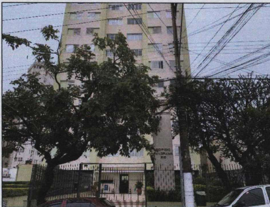
Foto 01. Fachada do condomínio.
