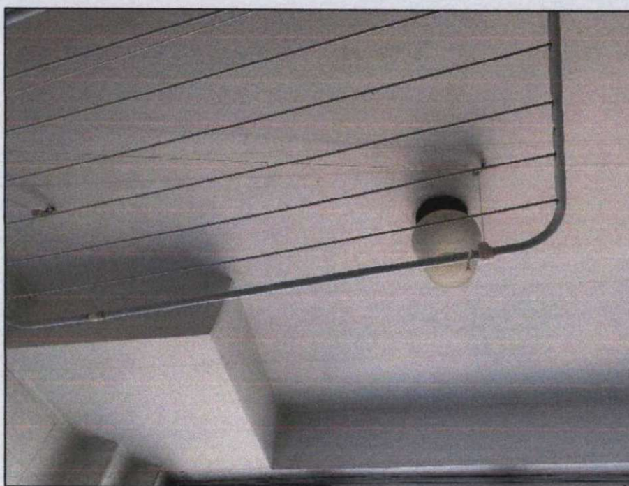
Foto 10. Detalhe do teto da área de serviço.
