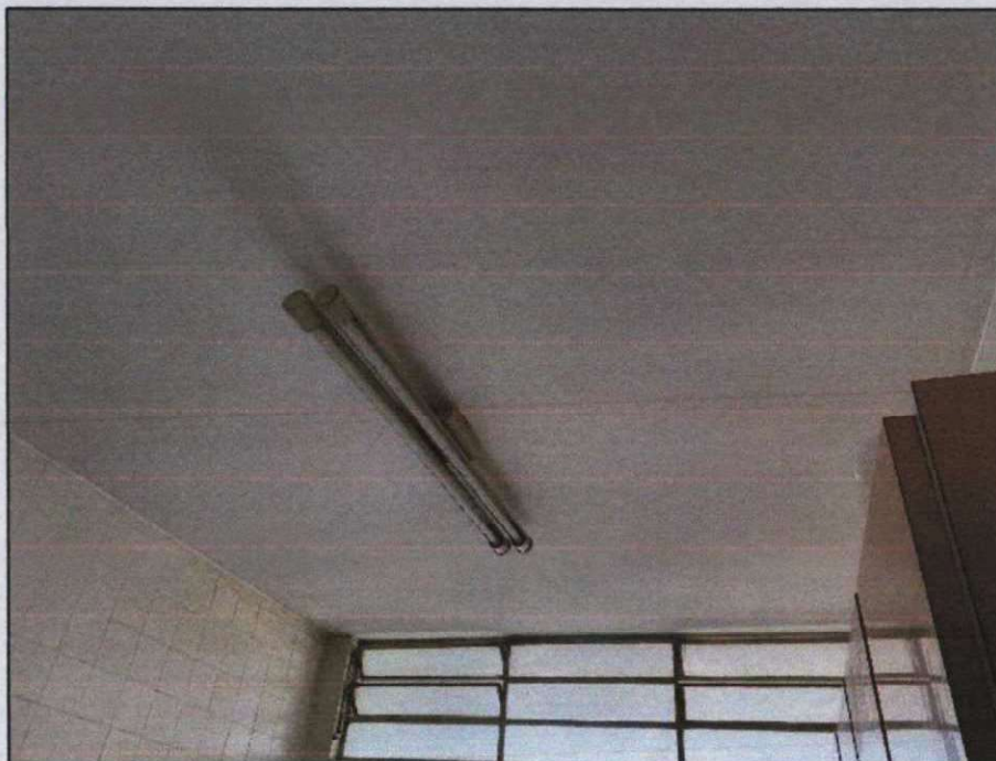
Foto 07. Detalhe do teto da cozinha.
