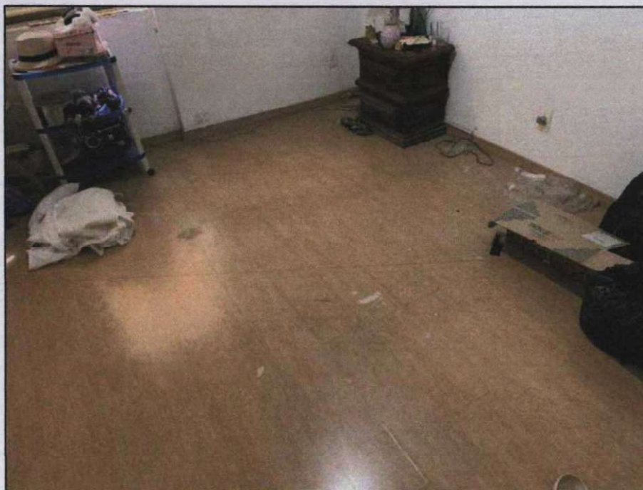
Foto 25. Detalhe do piso do quarto.
