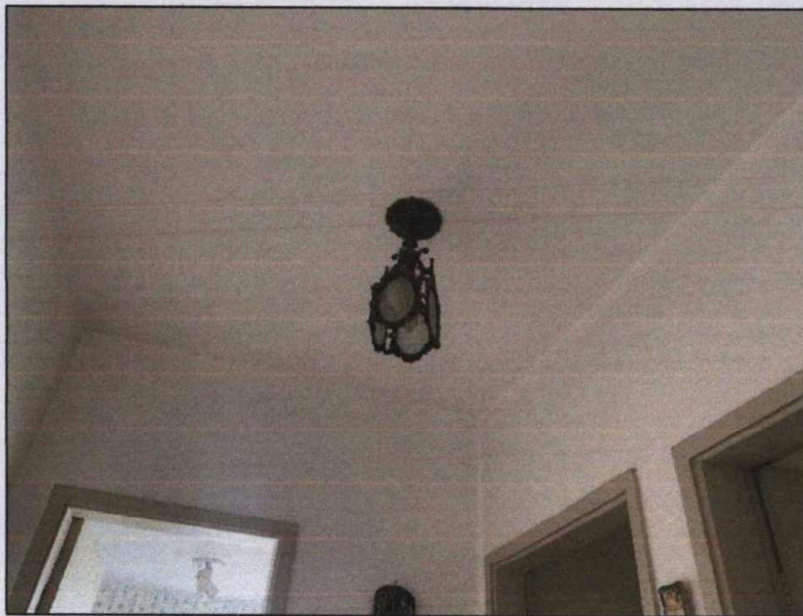
Foto 20. Detalhe do teto do hall.
