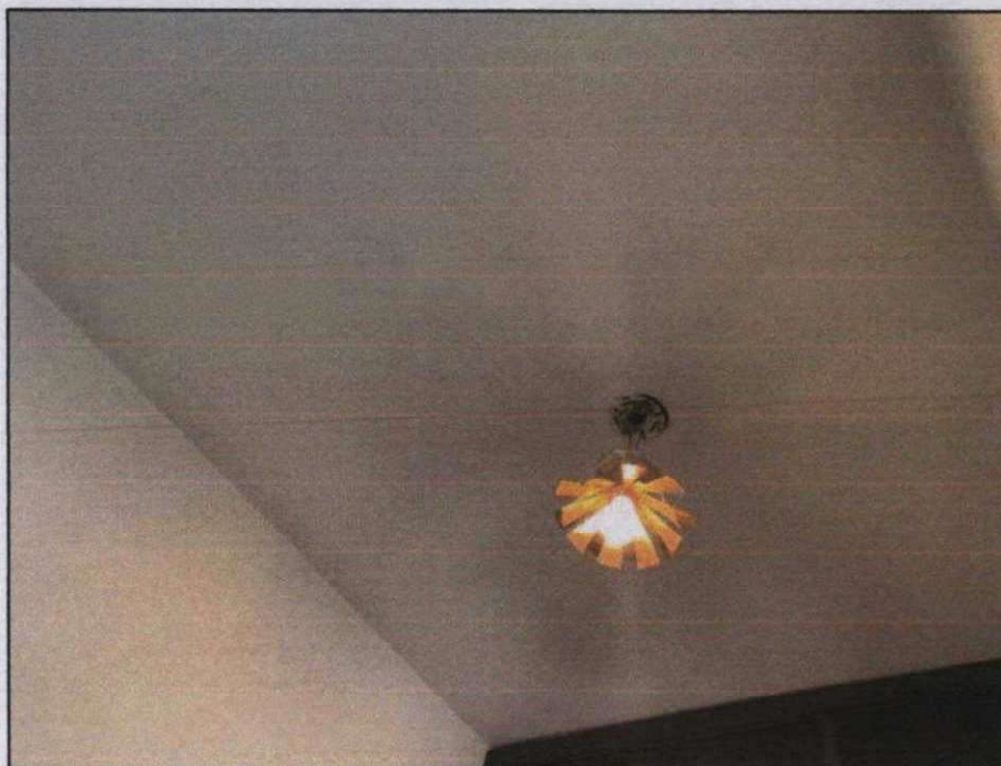
Foto 13. Detalhe do teto do quarto de serviço.
