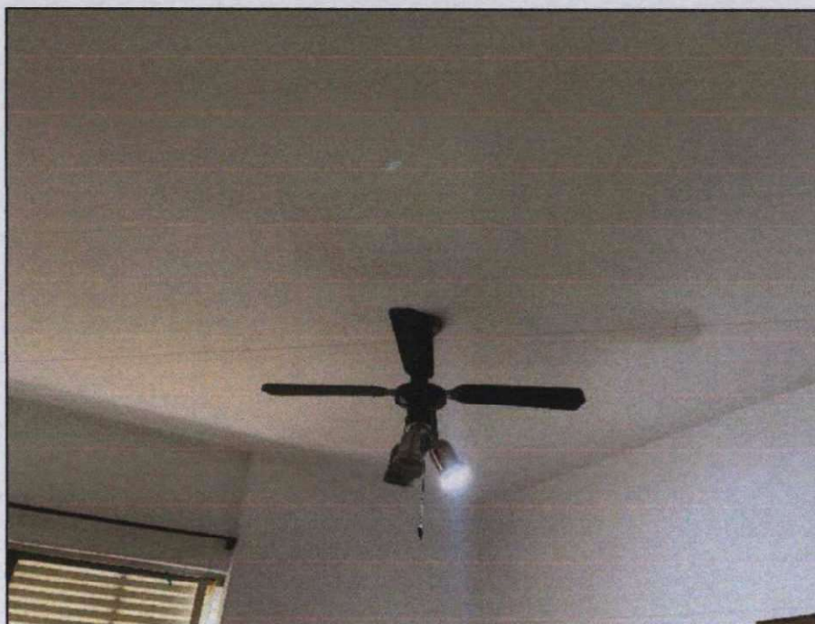
Foto 23. Detalhe do teto do quarto.
