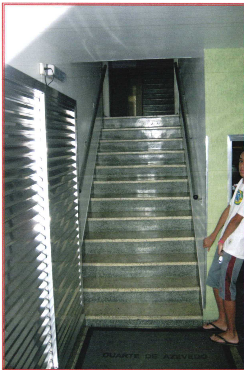
Foto nº 06: Vista do hall de entrada do edifício.
