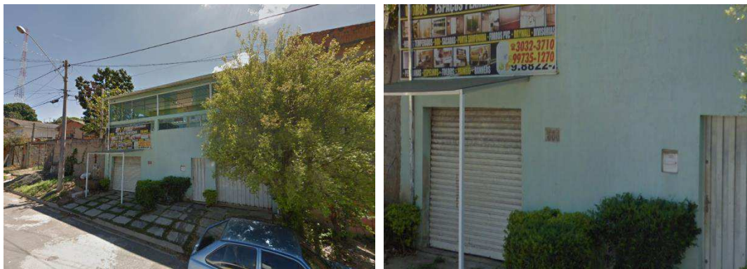
Vistada do logradouro
