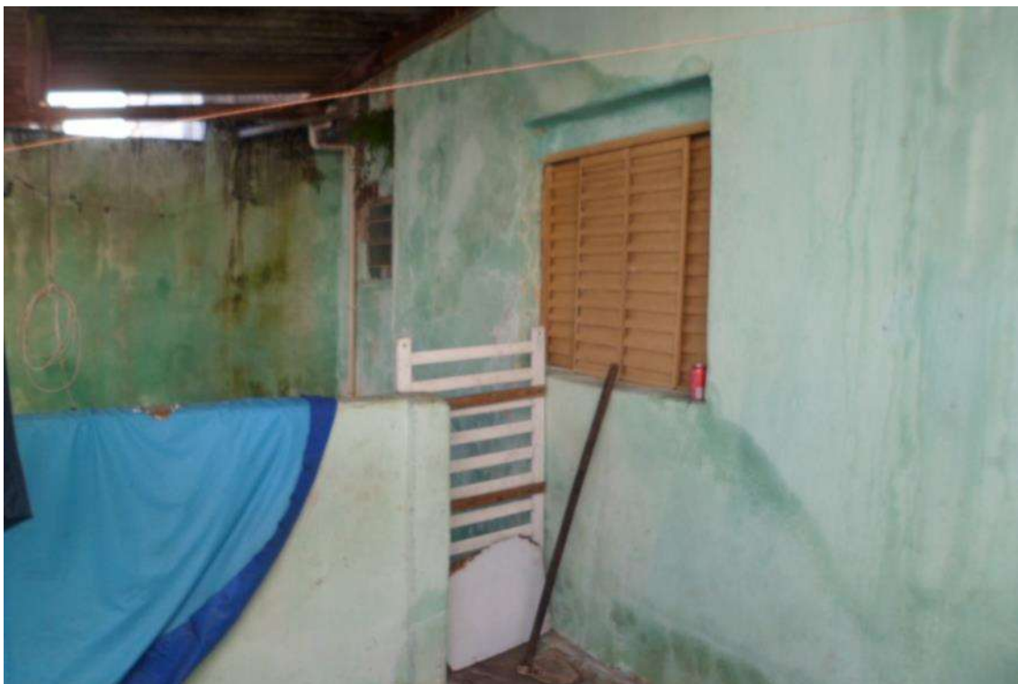
FOTO 3 – Vista da garagem.
