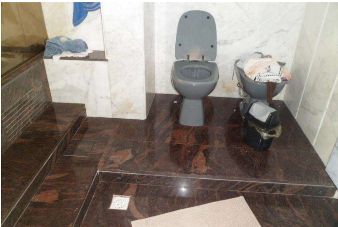
FOTO 25 – Vista do banheiro da suíte.
