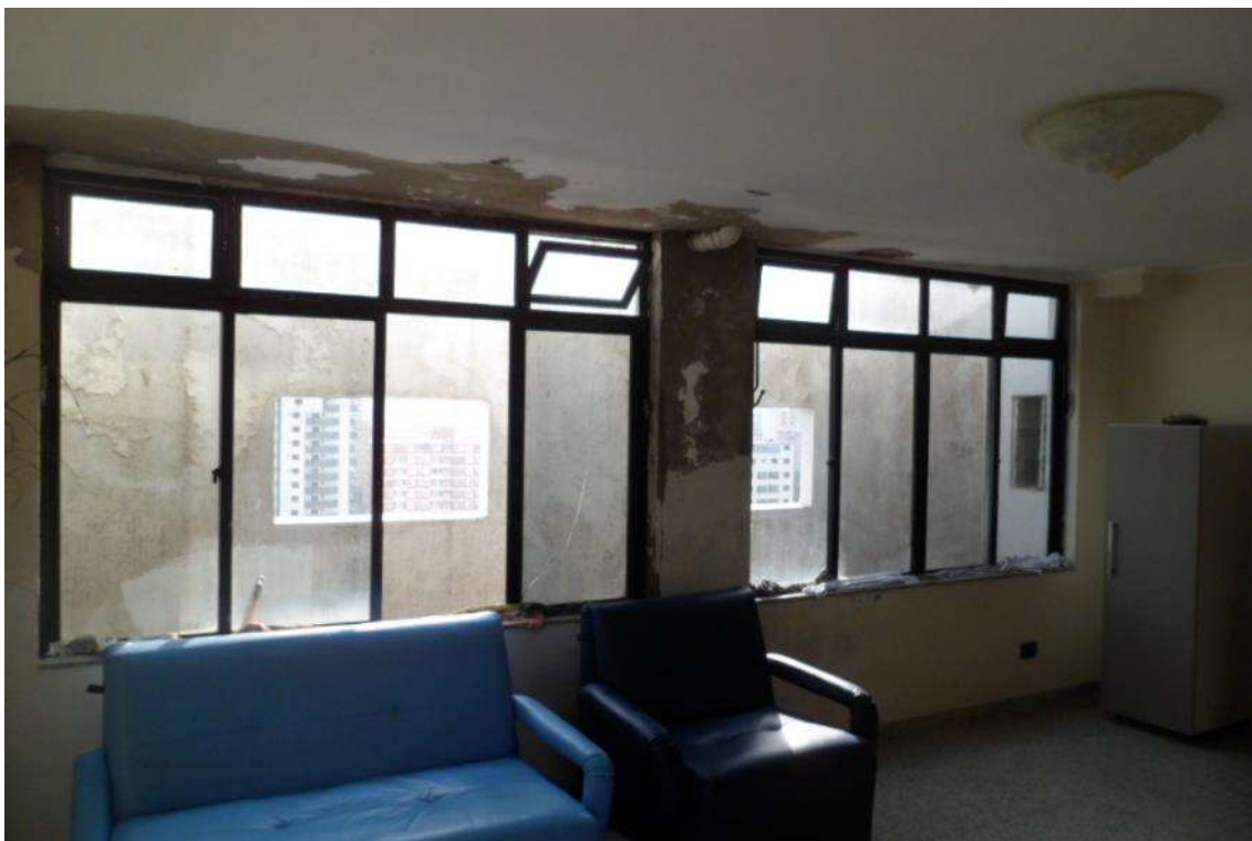
FOTO 20 – Vista do escritório.
