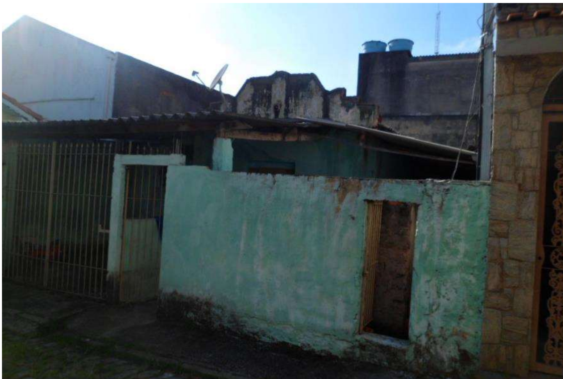
FOTO 2 – Vista, da fachada.
