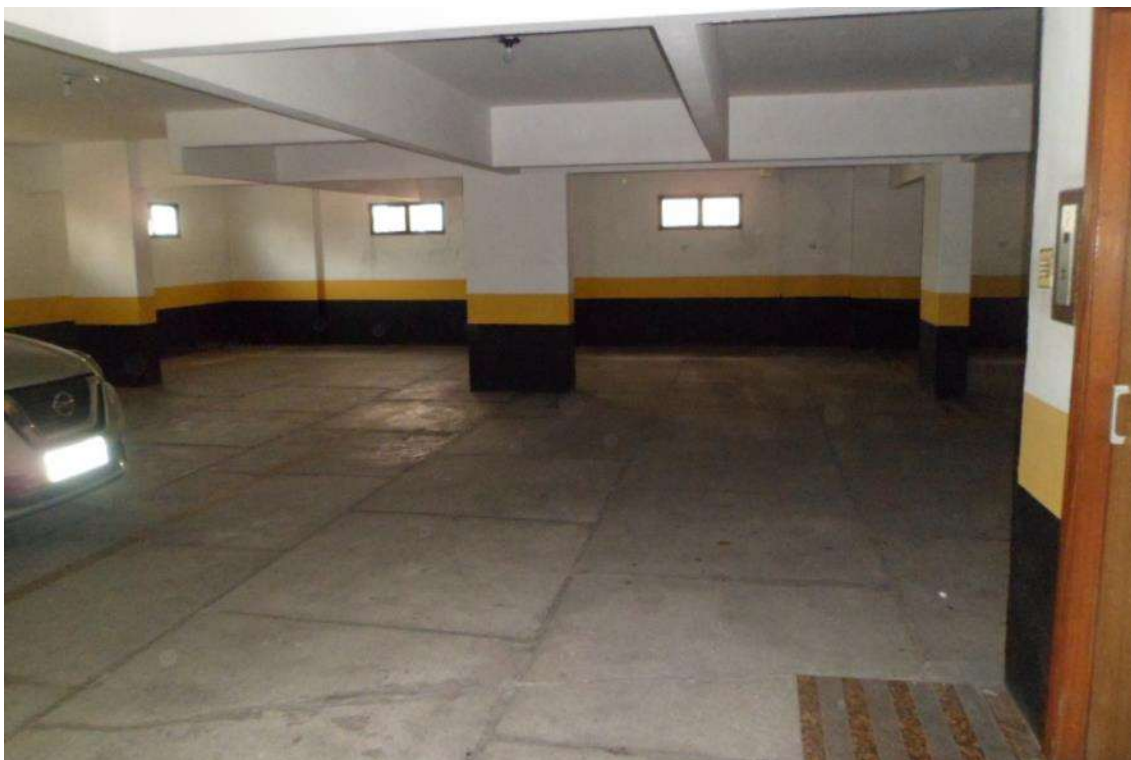
FOTO 32 – Vista da garagem do Edifício São Bento.
