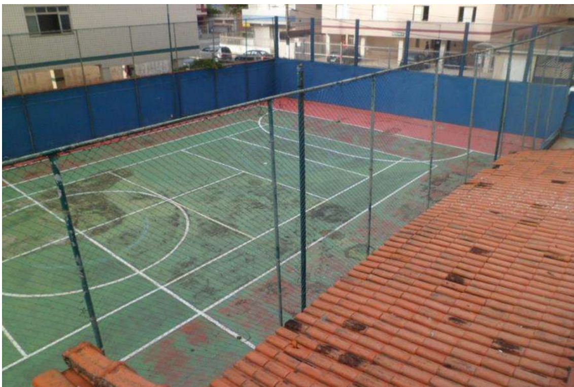
FOTO 31 – Detalhe da quadra poliesportiva do Edifício São Bento.
