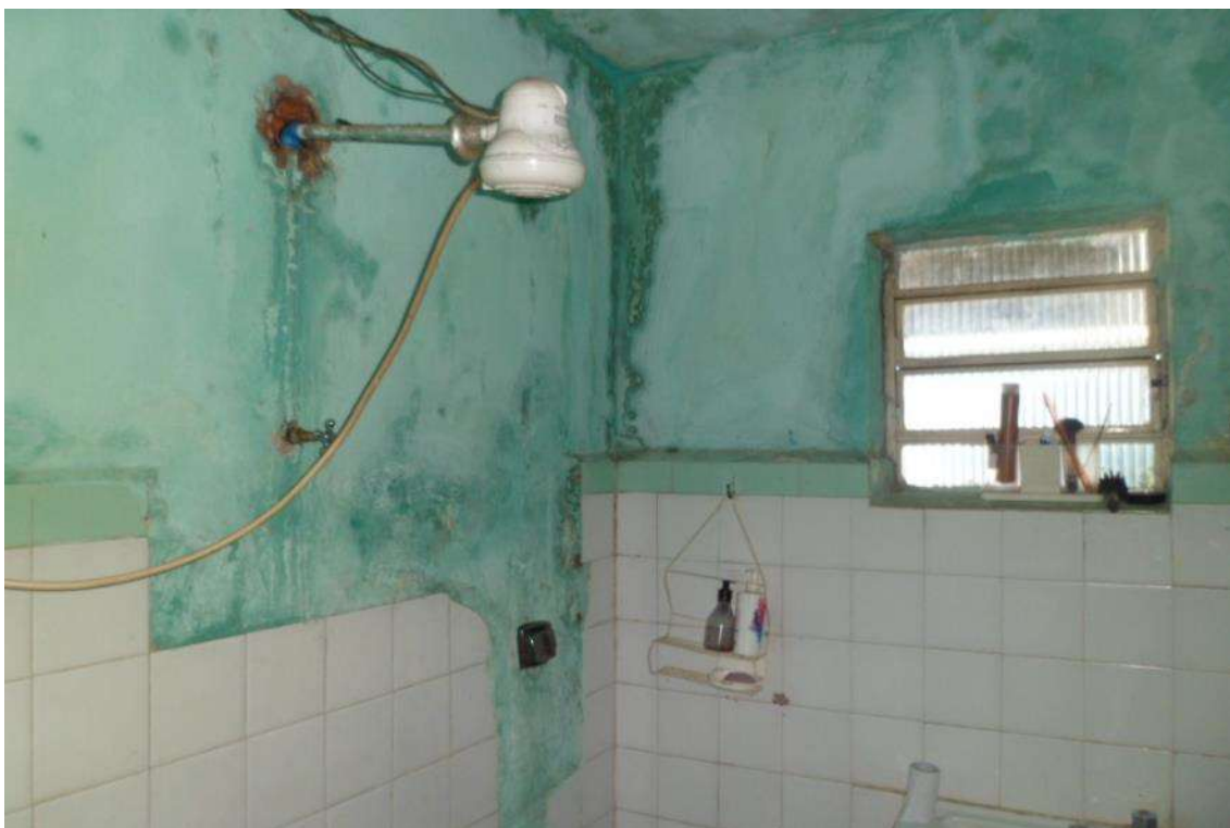
FOTO 10 – Vista do banheiro.
