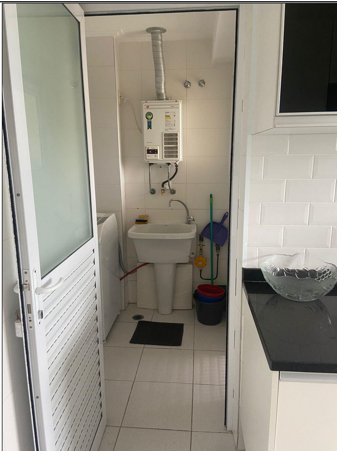
Imagem 19 – Área de Serviço – lavanderia.
