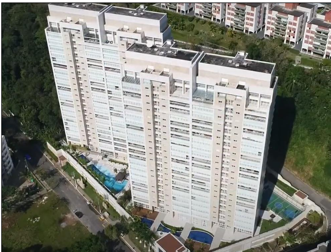
Imagem 1 – Fachada do Condomínio Verdemar (Torre A e Torre B).
