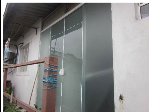
Foto 14: Vista geral da Casa 01 (fechada no momento da vistoria)
