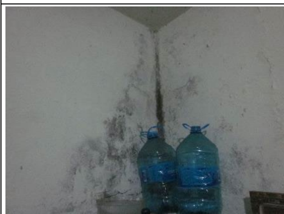
Foto 08: Detalhe de infiltração na cozinha
