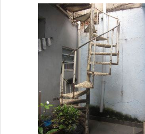
Foto 13: Vista da escada de acesso a casa à Casa 01
