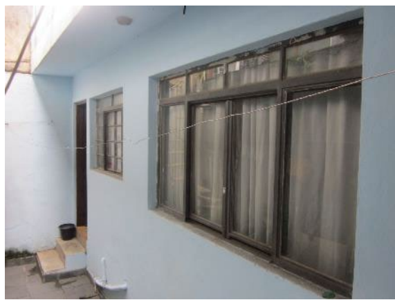
Foto 15: Vista geral da Casa 03
